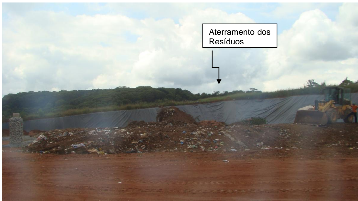
FIGURA 15: Área de aterramento dos resíduos sólidos
