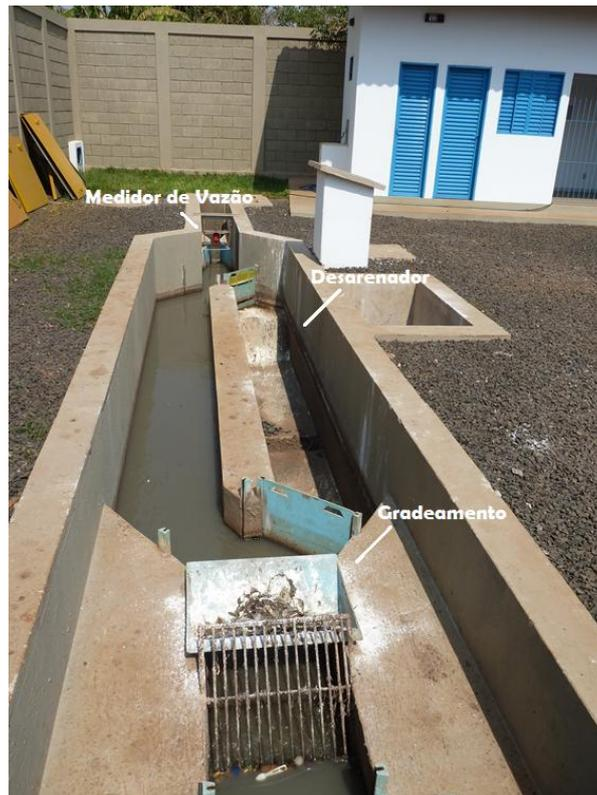
FIGURA 16 - Tratamento Preliminar: Estação Elevatória de Caçu
