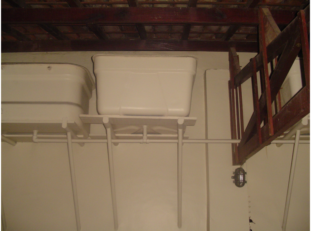
Figura 8.5: Antigos reservatórios superiores de água
