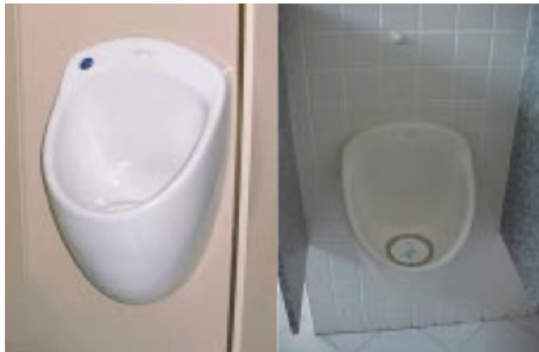
Figura 5.7: Mictório sem água
