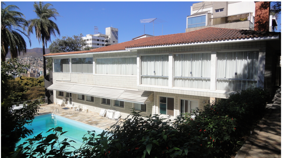
Figura 8.3: Foto atual da casa
