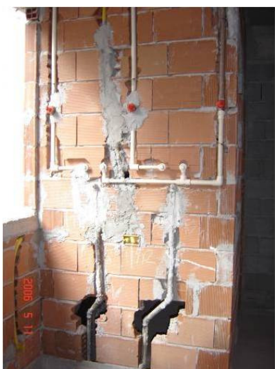
Figura 2.3: Alvenaria em componente cerâmico recortada após a execução.
