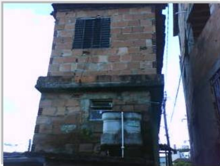
Figura 1.2: Residência sem estrutura de concreto armado.
