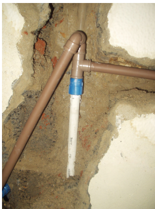
Figura 3.1: Quebra de parede para embutir a tubulação
