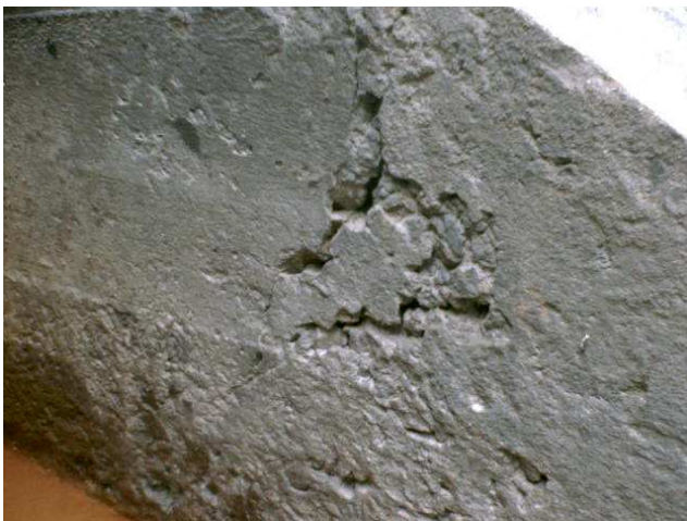
Figuras 4.63 e 4.64 – Presença de ninhos de concretagem nas paredes dos canais. Patologia decorrente da execução incorreta das estruturas, tendo o concreto sido vibrado incorretamente.
