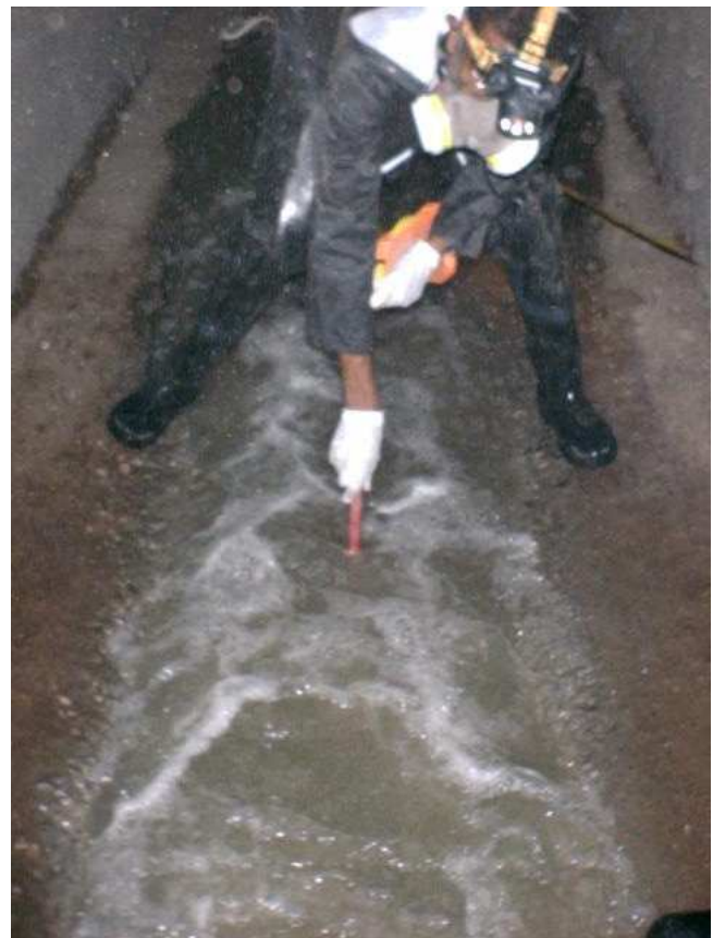
Figuras 4.7 e 4.8 – Desgaste por erosão no fundo de galeria causada pelo fluxo d'água. O fundo da galeria foi completamente erodido e não mais existe. Nota-se pelo bastão na mão do vistoriador que a grande profundidade da erosão abaixo do leito do canal.
