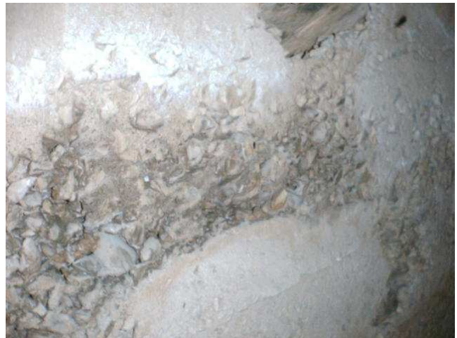
Figuras 4.63 e 4.64 – Presença de ninhos de concretagem nas paredes dos canais. Patologia decorrente da execução incorreta das estruturas, tendo o concreto sido vibrado incorretamente.
