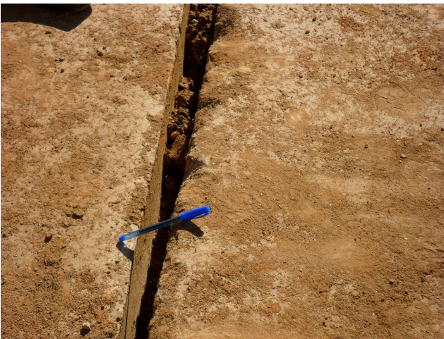
Figuras 7.51 e 4.52 – O canal localizado na rua Tocantins possui curva acentuada. Tal característica dificulta a execução de estruturas pré moldadas, o que muitas vezes torna preferível construir tais trechos em concreto usinado in loco.
