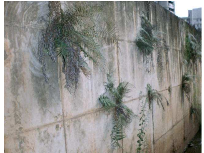
Figuras 4.47 e 4.48 – Presença de plantas e matéria orgânica (lodo) em canais abertos. Sua presença causa deterioração do concreto, além de criar caminhos por onde a água pode percolar. Os mecanismos de biodegradação, que promovem o envelhecimento, comprometem a durabilidade e integridade do concreto, podem se manifestar através de formação de biofilme, ataque ácido, tensões provocadas pela cristalização de sais e complexação.
