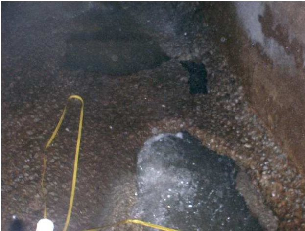
Figuras 4.5 e 4.6 – Desgaste por erosão e cavitação no fundo de galeria causada pelo fluxo d'água.
