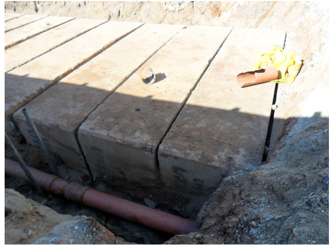
Figuras 4.49 e 4.50 – Canal em aduelas pré-fabricadas sofreu recalques e deslocamentos. A causa apontada para a origem da patologia foi a falta do berço de concreto para assentamento das aduelas.
