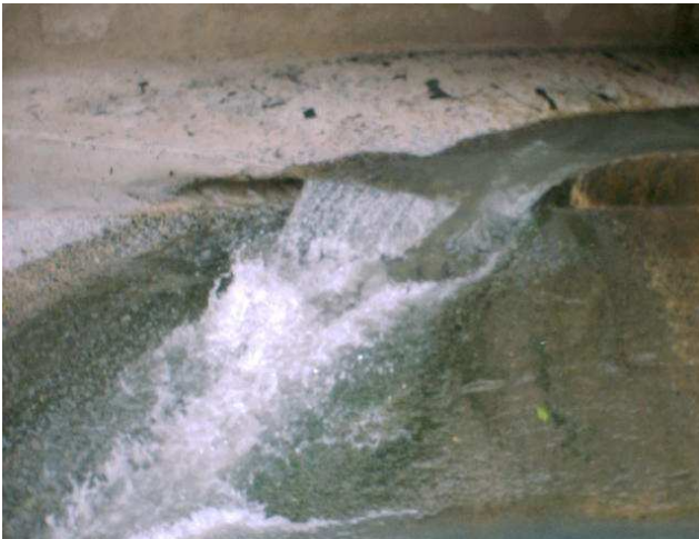
Figuras 4.9 e 4.10 – Desgaste em degraus de canais abertos causada pelo fluxo d'água, em área próxima a degrau, que é um ponto susceptível a este tipo de ocorrência, pois cria diferenças de pressão que favorecem o aparecimento de bolhas no fluxo que são as causadoras dos danos por cavitação.
