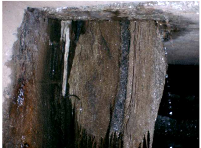
Figuras 4.45 e 4.46 – Presença de raízes dentro das galerias. As raízes criam tensões nas estruturas que originam trincas e deslocamentos. Além disso, criam caminhos por onde a água percola pela estrutura, facilitando o transporte de outros agentes agressivos para seu interior. e podem gerar outras patologias como por exemplo a carbonatação.
