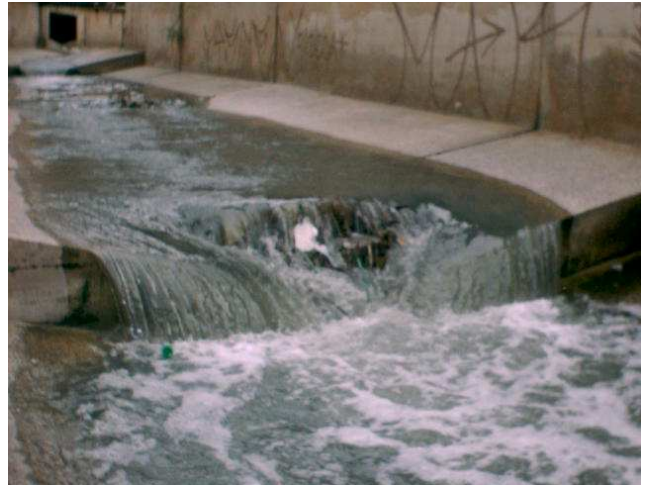
Figuras 4.9 e 4.10 – Desgaste em degraus de canais abertos causada pelo fluxo d'água, em área próxima a degrau, que é um ponto susceptível a este tipo de ocorrência, pois cria diferenças de pressão que favorecem o aparecimento de bolhas no fluxo que são as causadoras dos danos por cavitação.
