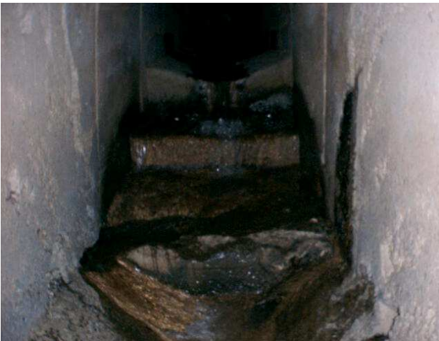
Figuras 4.11 e 4.12 – Desgaste por erosão e cavitação em área de degraus. O desgaste se soma a corrosão de armaduras e acúmulo de lixo e sedimentos na segunda figura.
