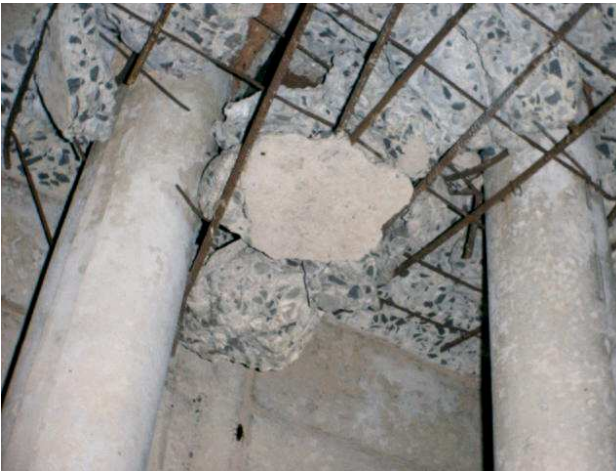
Figura 4.67 e 4.68 – Detalhe de estaca cravada dentro da galeria apresentada na figura 4.66, mostrando os extensos danos causados à laje do teto da galeria. A Segunda figura mostra o colapso de uma estrutura de concreto de canal aberto, que foi executada sobre uma estrutura de gabião existente. A base de baião é muito flexível e propensa a grandes deformações, o que foi incompatível com a estrutura rígida de concreto feita por cima desta.
