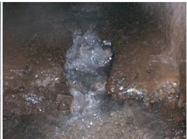
Figuras 4.3 e 4.4 – Desgaste por erosão e cavitação no fundo de galeria causada pelo fluxo d'água. O finos foram carreados pelo fluxo de água, ficando exposto o agregado graúdo.
