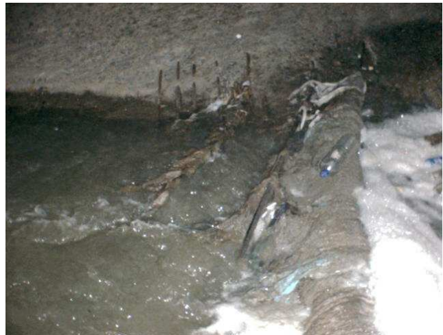
Figuras 4.11 e 4.12 – Desgaste por erosão e cavitação em área de degraus. O desgaste se soma a corrosão de armaduras e acúmulo de lixo e sedimentos na segunda figura.
