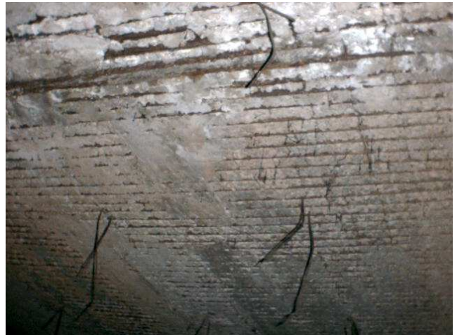
Figuras 4.31 e 4.32 – Corrosão generalizada das armaduras em lajes de teto de galeria, acompanhada de manchas indicando processos de patologia química do concreto. Nota-se que as ferragens estão se desprendendo e o fluxo faz com que fiquem retorcidas como nota-se na primeira figura.
