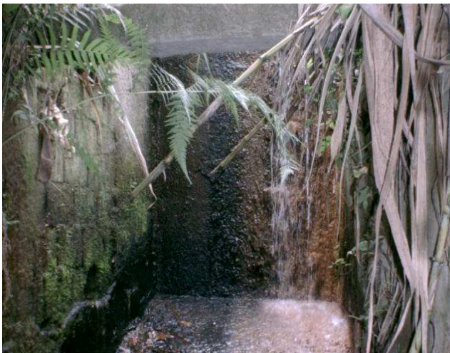
Figuras 4.47 e 4.48 – Presença de plantas e matéria orgânica (lodo) em canais abertos. Sua presença causa deterioração do concreto, além de criar caminhos por onde a água pode percolar. Os mecanismos de biodegradação, que promovem o envelhecimento, comprometem a durabilidade e integridade do concreto, podem se manifestar através de formação de biofilme, ataque ácido, tensões provocadas pela cristalização de sais e complexação.
