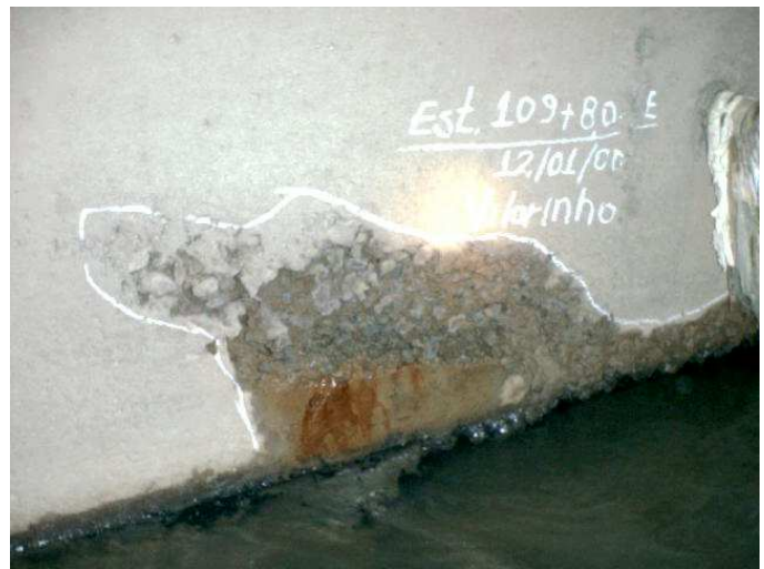
Figuras 4.61 e 4.62 – Presença de ninhos de concretagem nas paredes dos canais. Patologia decorrente da execução incorreta das estruturas, tendo o concreto sido vibrado incorretamente. Nota-se na primeira figura que a armadura ficou exposta por falta de material de recobrimento, o que abre espaço para a corrosão da armadura.
