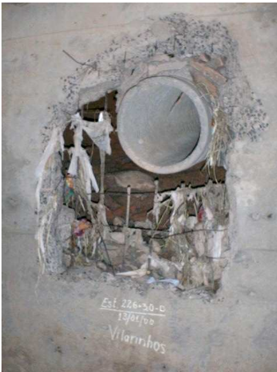
Figuras 4.29 e 4.30 – Detalhe de ligação de redes tubulares nas paredes e tetos dos canais. Realizada de maneira imprópria, deixa exposta as armaduras, o que propicia o início de processo patológico. O arremate e acabamento corretos das ligações das redes coletoras aos canis é fundamental para o não aparecimento das manifestações patológicas.
