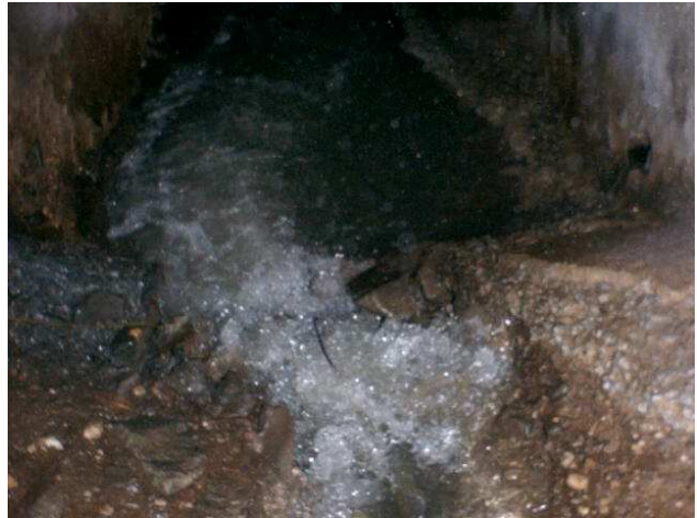
Figuras 4.5 e 4.6 – Desgaste por erosão e cavitação no fundo de galeria causada pelo fluxo d'água.
