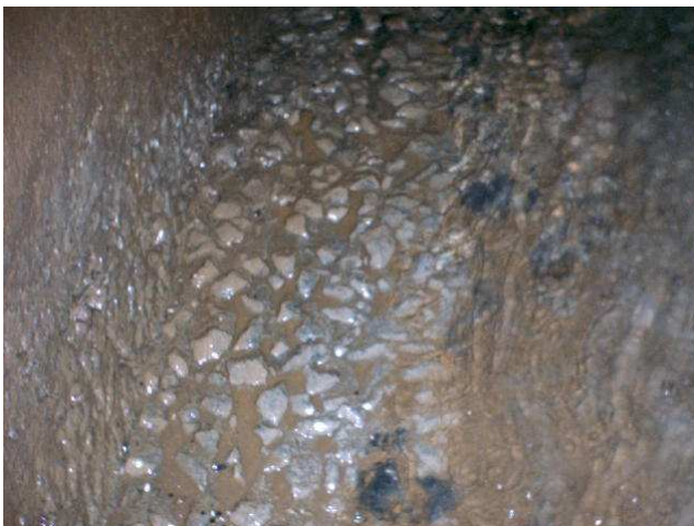
Figuras 4.3 e 4.4 – Desgaste por erosão e cavitação no fundo de galeria causada pelo fluxo d'água. O finos foram carreados pelo fluxo de água, ficando exposto o agregado graúdo.
