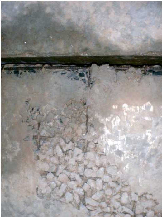
Figuras 4.61 e 4.62 – Presença de ninhos de concretagem nas paredes dos canais. Patologia decorrente da execução incorreta das estruturas, tendo o concreto sido vibrado incorretamente. Nota-se na primeira figura que a armadura ficou exposta por falta de material de recobrimento, o que abre espaço para a corrosão da armadura.
