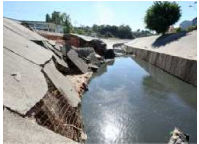
Figura 4.67 e 4.68 – Detalhe de estaca cravada dentro da galeria apresentada na figura 4.66, mostrando os extensos danos causados à laje do teto da galeria. A Segunda figura mostra o colapso de uma estrutura de concreto de canal aberto, que foi executada sobre uma estrutura de gabião existente. A base de baião é muito flexível e propensa a grandes deformações, o que foi incompatível com a estrutura rígida de concreto feita por cima desta.
