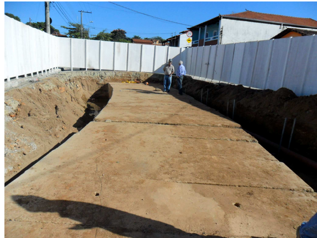
Figuras 7.51 e 4.52 – O canal localizado na rua Tocantins possui curva acentuada. Tal característica dificulta a execução de estruturas pré moldadas, o que muitas vezes torna preferível construir tais trechos em concreto usinado in loco.
