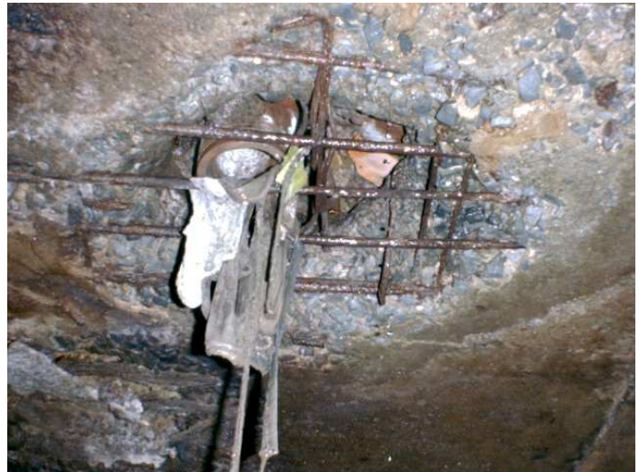
Figuras 4.29 e 4.30 – Detalhe de ligação de redes tubulares nas paredes e tetos dos canais. Realizada de maneira imprópria, deixa exposta as armaduras, o que propicia o início de processo patológico. O arremate e acabamento corretos das ligações das redes coletoras aos canis é fundamental para o não aparecimento das manifestações patológicas.
