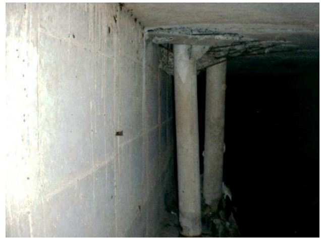
Figuras 4.65 e 4.66 – Presença de estacas de fundações de edifícios dentro das galerias. A cravação das estacas atravessou a laje de topo e de fundo das galerias, danificando severamente sua estrutura, mostrando situação extrema de mau uso da estrutura.
