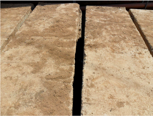
Figuras 4.49 e 4.50 – Canal em aduelas pré-fabricadas sofreu recalques e deslocamentos. A causa apontada para a origem da patologia foi a falta do berço de concreto para assentamento das aduelas.
