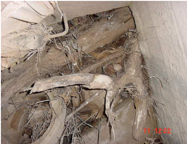
Figuras 4.45 e 4.46 – Presença de raízes dentro das galerias. As raízes criam tensões nas estruturas que originam trincas e deslocamentos. Além disso, criam caminhos por onde a água percola pela estrutura, facilitando o transporte de outros agentes agressivos para seu interior. e podem gerar outras patologias como por exemplo a carbonatação.
