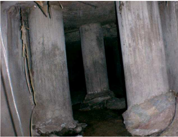
Figuras 4.65 e 4.66 – Presença de estacas de fundações de edifícios dentro das galerias. A cravação das estacas atravessou a laje de topo e de fundo das galerias, danificando severamente sua estrutura, mostrando situação extrema de mau uso da estrutura.
