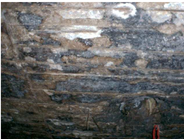
Figuras 4.31 e 4.32 – Corrosão generalizada das armaduras em lajes de teto de galeria, acompanhada de manchas indicando processos de patologia química do concreto. Nota-se que as ferragens estão se desprendendo e o fluxo faz com que fiquem retorcidas como nota-se na primeira figura.
