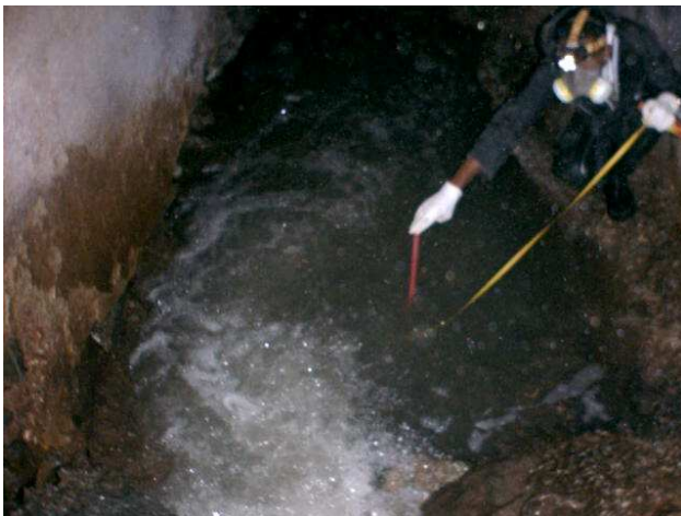
Figuras 4.7 e 4.8 – Desgaste por erosão no fundo de galeria causada pelo fluxo d'água. O fundo da galeria foi completamente erodido e não mais existe. Nota-se pelo bastão na mão do vistoriador que a grande profundidade da erosão abaixo do leito do canal.
