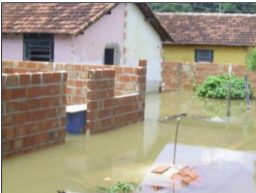
Figura 4.13 Inundação do Bairro COHAB Fonte ( Arquivo Pessoal)
