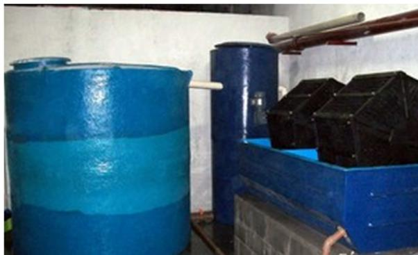
Figura 5.5 Filtros de tratamento de água cinza
