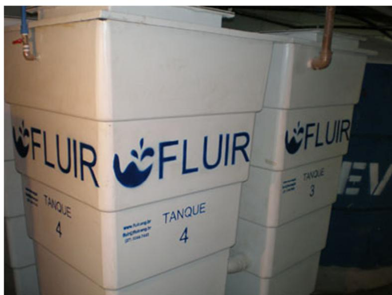
Figura 5.7 ETAC- Estação de tratamento de água cinza
