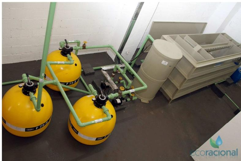
Figura 5.6 Estação de tratamento de água cinza ETAC 1000
