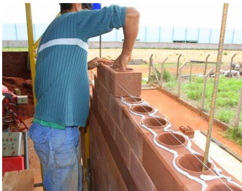
FIGURA 3.3 – Assentamento de alvenaria com redução de material para assentamento.
