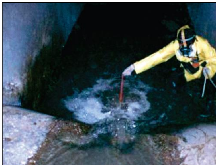
Figura 4.7: Cratera com profundidade superior a um metro, logo após degrau. (Fonte: AGUIAR, 2006)
