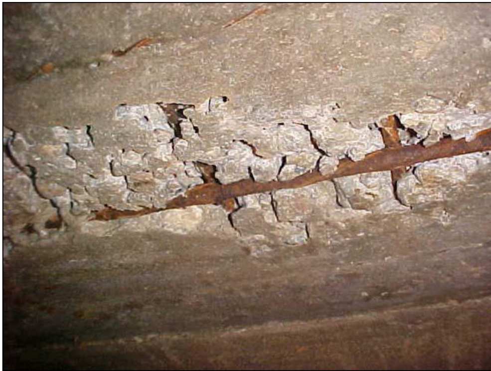
Figura 3.2: Falta de estanqueidade nas fôrmas causando fuga da argamassa. Fonte: (AGUIAR, 2006)
