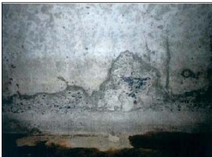
Figura 4.21: Ninhos de pedra em parede de uma galeria. Fonte: (AGUIAR & BAPTISTA, 2009)
