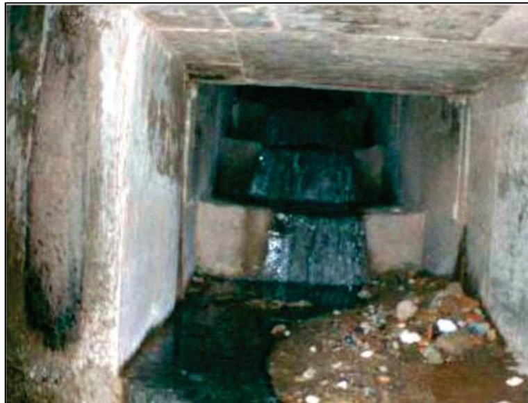
Figura 4.6: Galeria construída com degraus, a fim de reduzir a velocidade do fluxo da água. (Fonte: AGUIAR, 2006)
