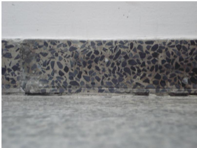
**FIGURA 113:** Piso marmorite: detalhe do rodapé original da edificação (1º subsolo), após recuperação. Foto da autora.
