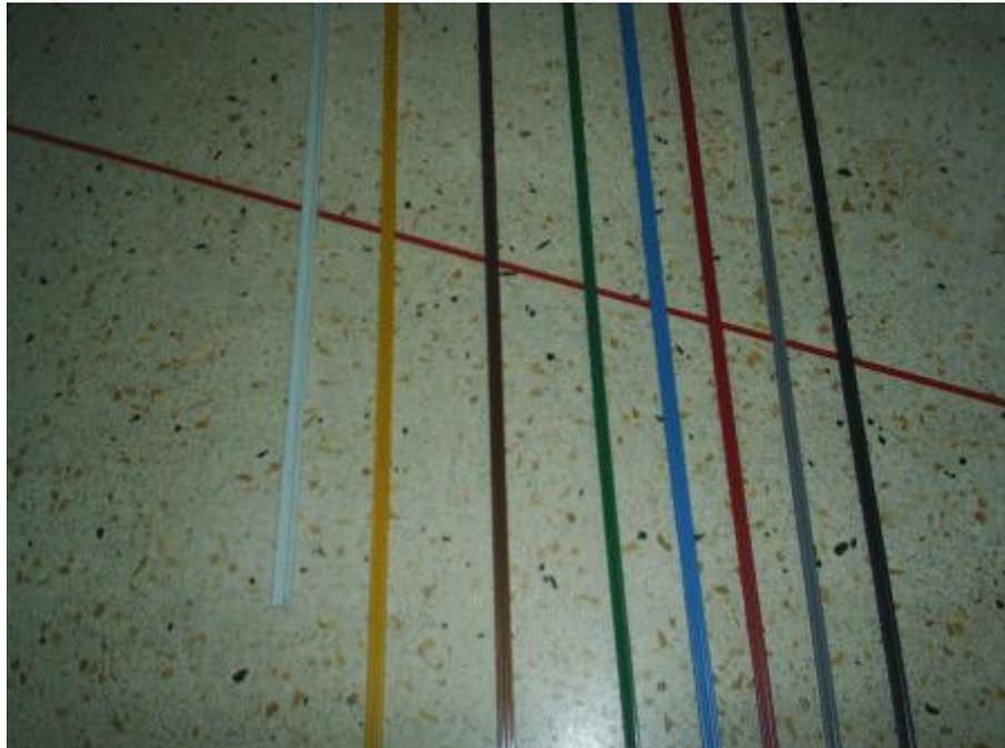
**FIGURA 39:** Piso granilite. Detalhe de coloração das juntas plásticas
