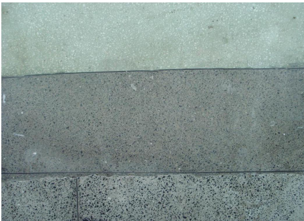
**FIGURA 116:** Piso marmorite: detalhe de três estágios de execução – piso original (faixa inferior, cinza), soleira do rodapé executada em 2008 (cinza escuro) e piso externo (verde, também executado em 2008, em outra etapa da obra). Foto da autora.
