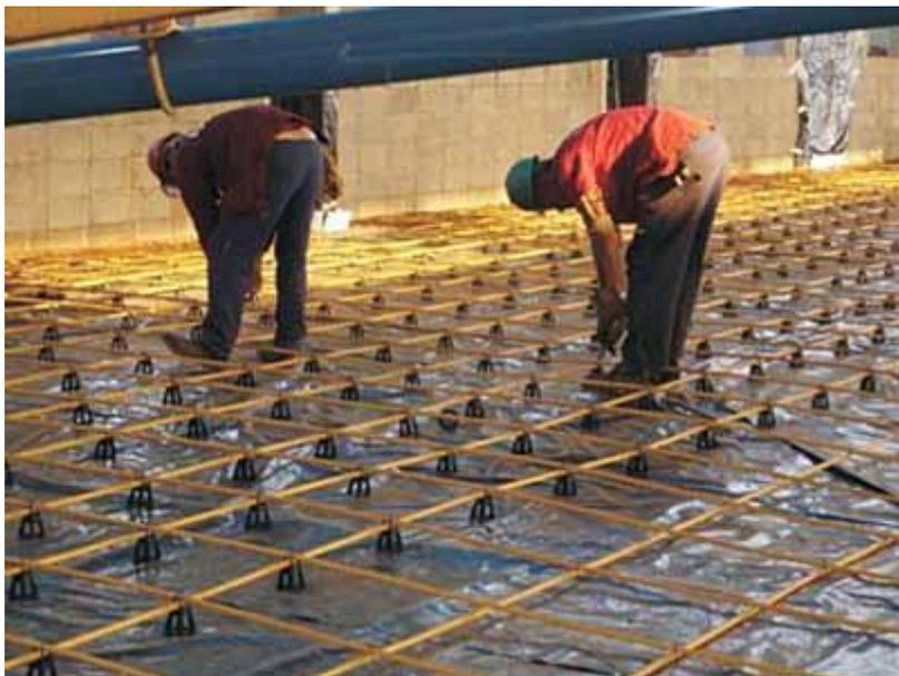
**FIGURA 51:** Representação gráfica do processo executivo do piso de concreto
