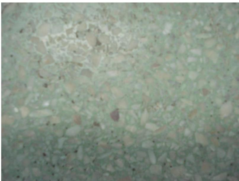
**FIGURA 97:** Piso marmorite original, após recuperação - detalhe da superfície.
