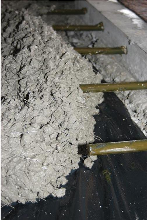
**FIGURA 55:** Fibras metálicas adicionadas ao concreto em piso.
