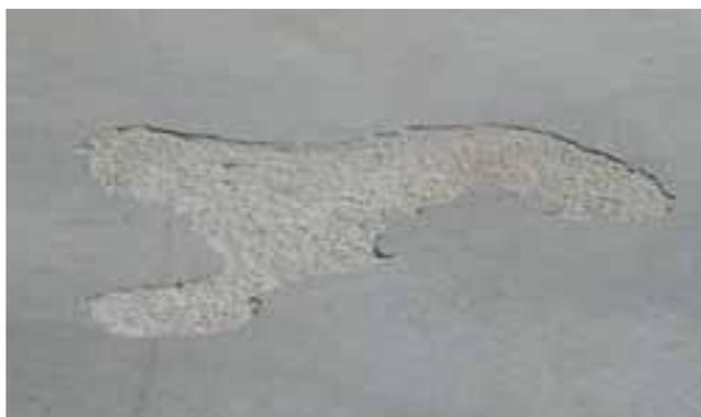
**FIGURA 77:** Delaminação. Fonte: Portal PI – Pisos Industriais
