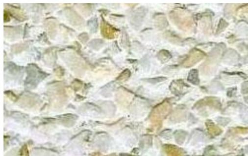
**FIGURA 44:** Detalhe piso tipo fulgê
