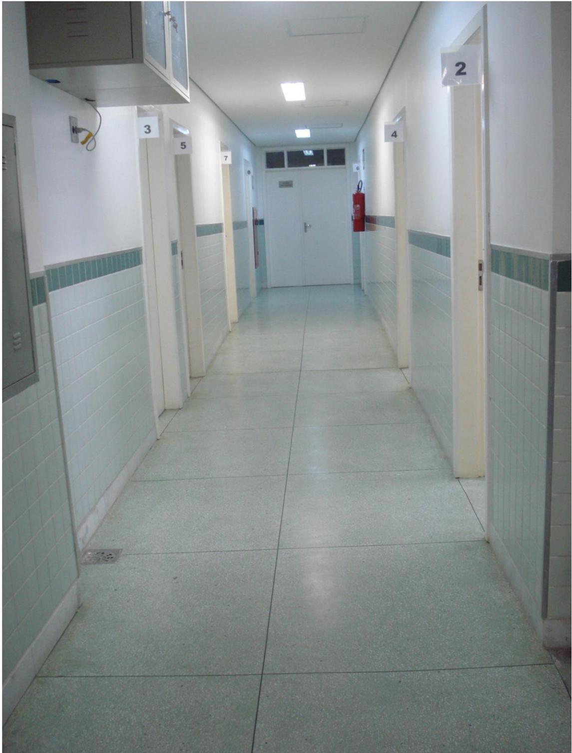
**FIGURA 107:** Piso marmorite executado em 2008: detalhe do corredor principal do 1º subsolo. Foto da autora.
