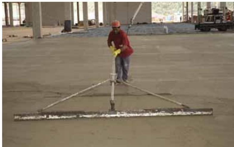
**FIGURA 63:** Rodo de corte. Fonte: Mario Oscar Pisos Industriais
