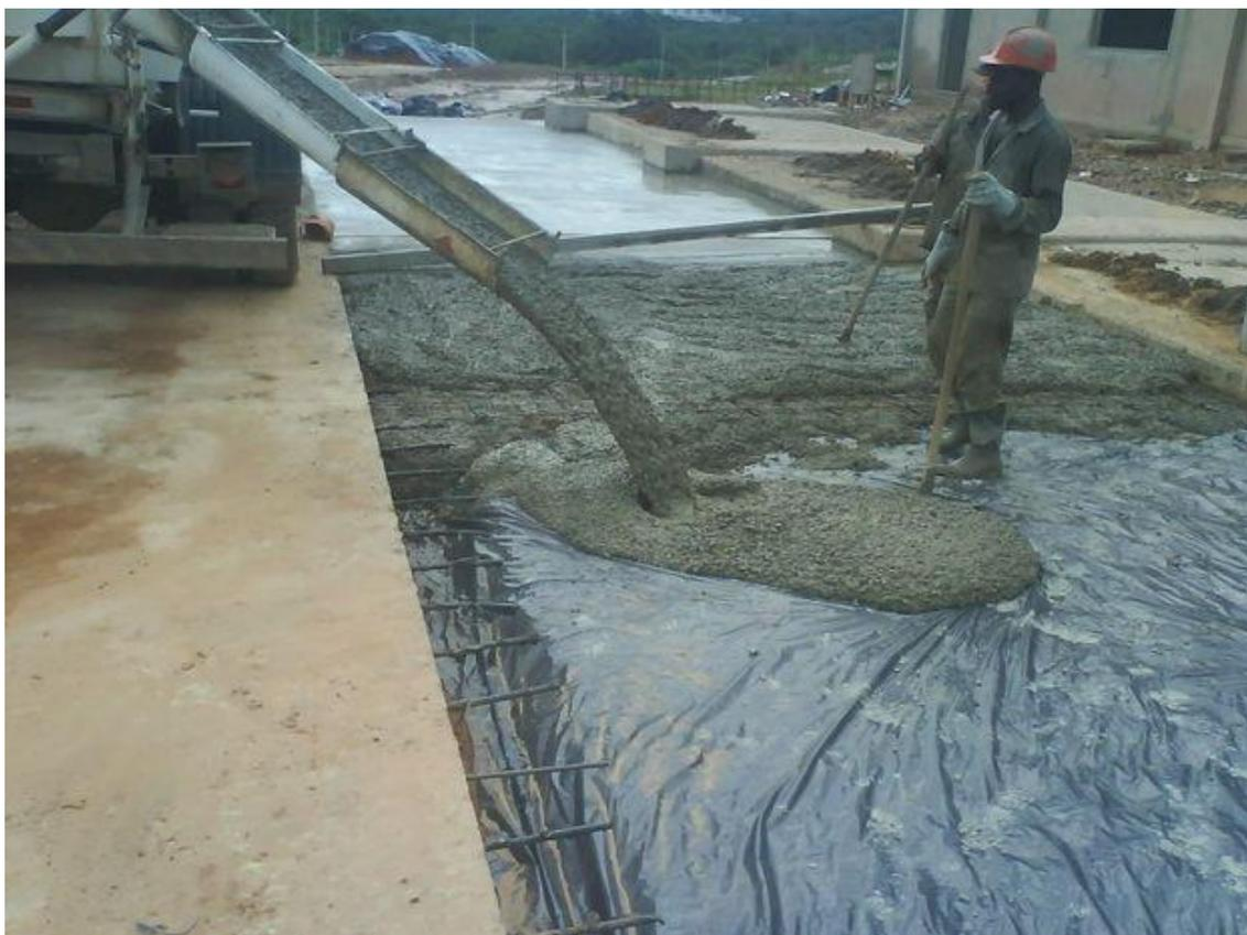
**FIGURA 59:** Lançamento do concreto. Fonte: Mario Oscar Pisos Industriais
