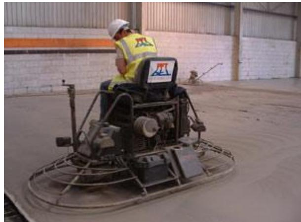
**FIGURA 68:** Alisadora dupla de alta rotação com disco de flotação para argamassamento da superfície.
