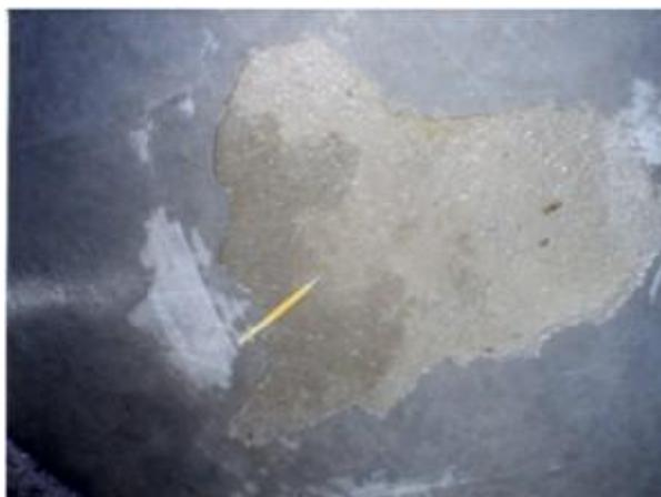
**FIGURA 79:** Delaminação em piso de concreto. Fonte: Portal PI - Pisos Industriais
