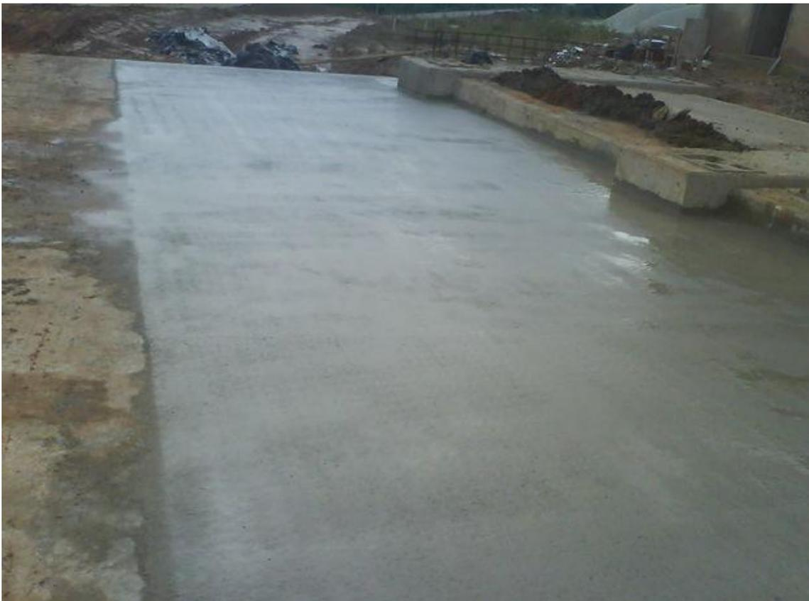
**FIGURA 65:** Piso de concreto: processo executivo. Fonte: Mario Oscar Pisos Industriais
