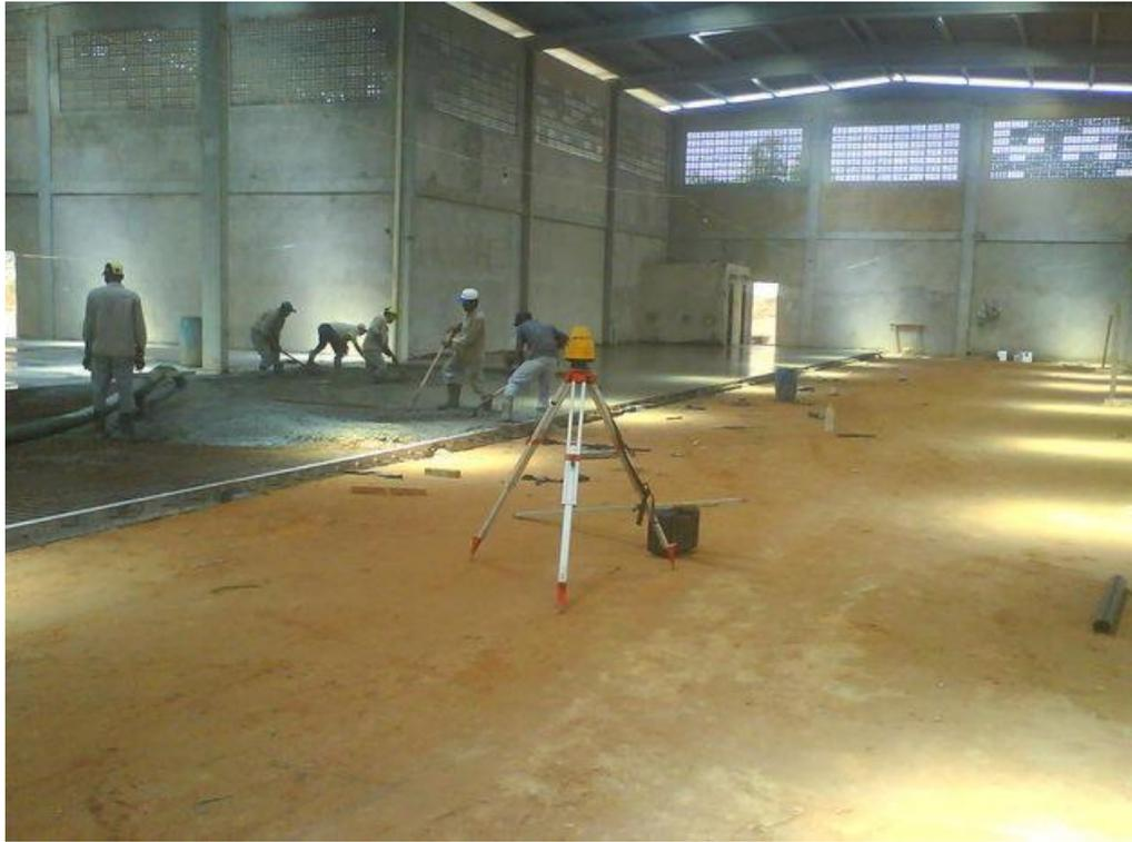
**FIGURA 62:** Piso de concreto – execução. Fonte: Mario Oscar Pisos Industriais
