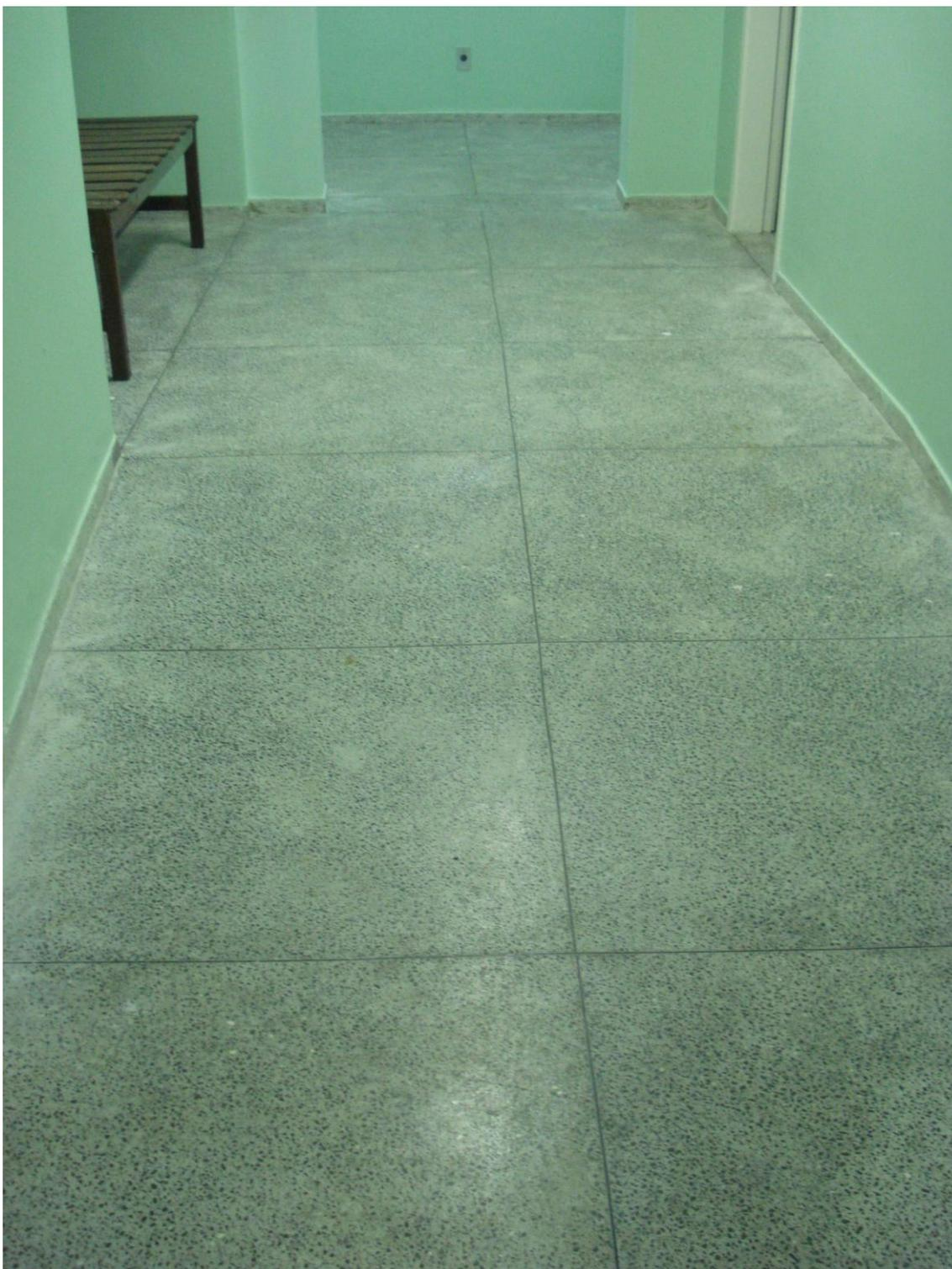
**FIGURA 111:** Piso marmorite: piso original do 1º subsolo, após recuperação.
