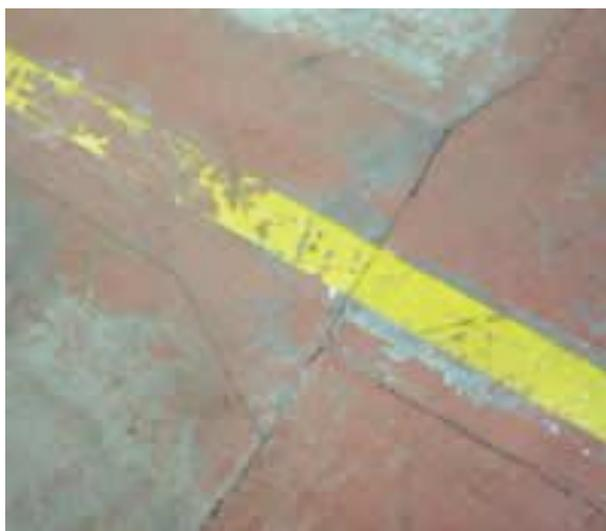
**FIGURA 82:** Formato inadequado de junta. Recuperação: reparo com lábio polimérico.
