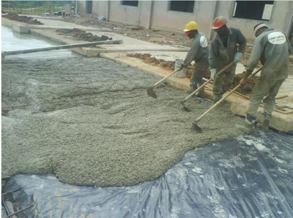
**FIGURA 60:** Lançamento do concreto. Fonte: Mario Oscar Pisos Industriais
