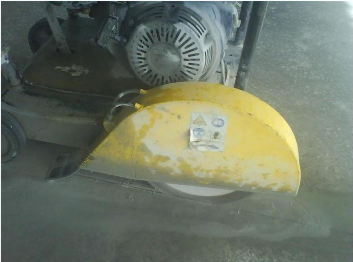
**FIGURA 69:** Corte das juntas em piso de concreto.
