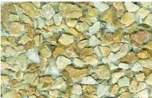
**FIGURA 43:** Detalhe piso tipo fulgê
