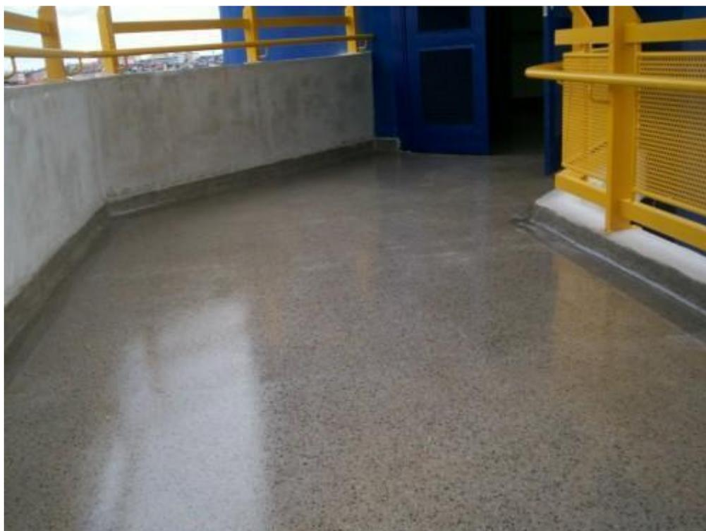
**FIGURA 71:** Piso de concreto polido.
