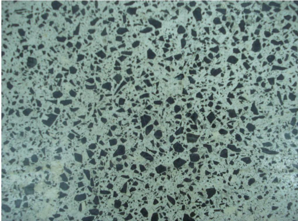
**FIGURA 112:** Piso marmorite cinza original, após recuperação: detalhe da superfície e granulometria. Foto da autora.
