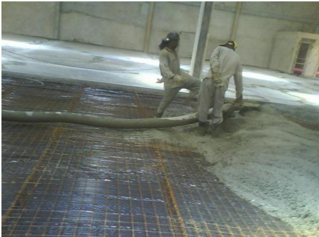
**FIGURA 61:** Lançamento do concreto. Fonte: Mario Oscar Pisos Industriais
