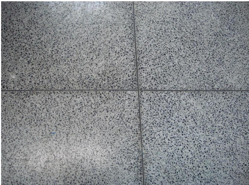
**FIGURA 115:** Piso marmorite: piso original do 1º subsolo após recuperação. Foto da autora.
