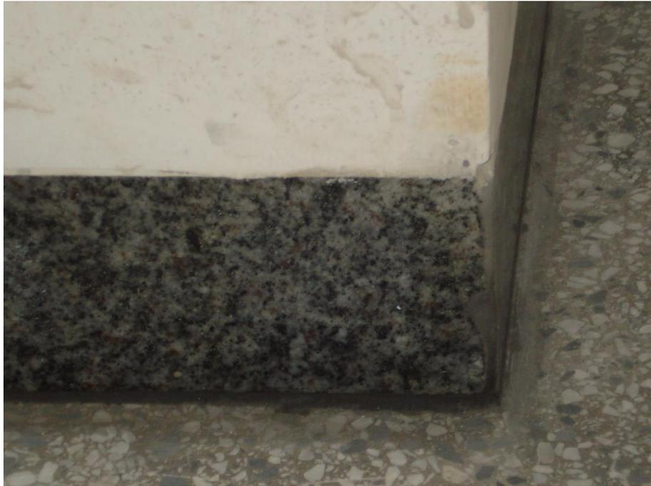
**FIGURA 121:** C.S. Mangueiras - piso marmorite após primeiro polimento – detalhe da junção com o rodapé. Foto da autora
