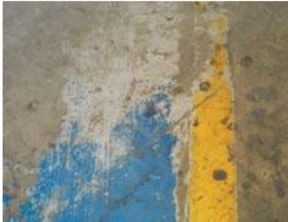
**FIGURA 74:** Desgaste por abrasão. Fonte: Portal PI – Pisos Industriais
