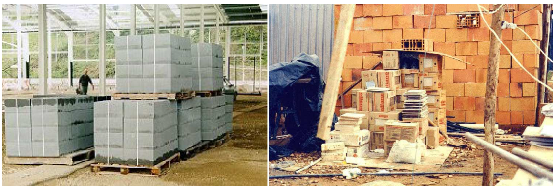
Fig. 06 – Comparação entre um estoque de canteiro organizado e um desorganizado. (ANDERY, 2009)
