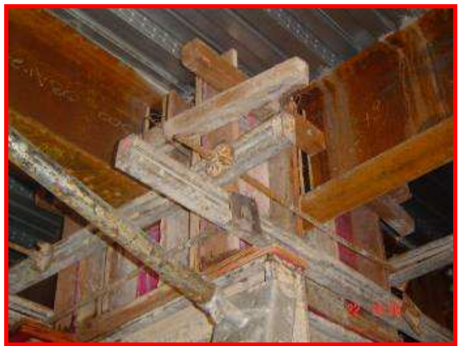
Figuras 7 e 8: Complexidade da Estrutura – Forma e Armação Fonte: O autor
