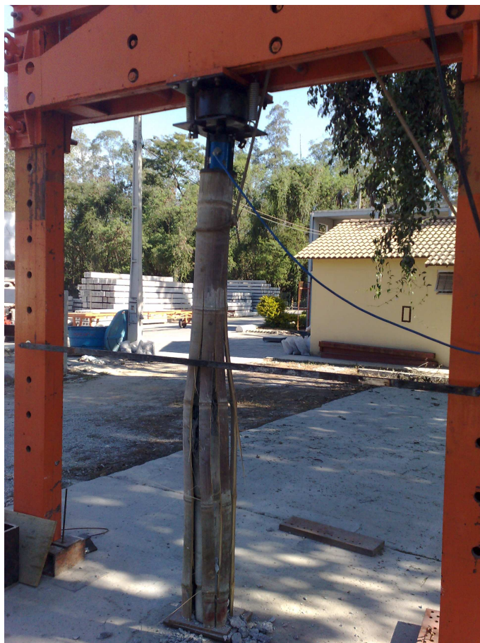
Figura 4.3: Ruptura explosiva registrada no centro do pilar
