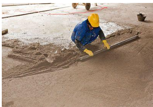
Figura 22 – Regularização da superfície Fonte: Virginia Pezzolo (2007)
