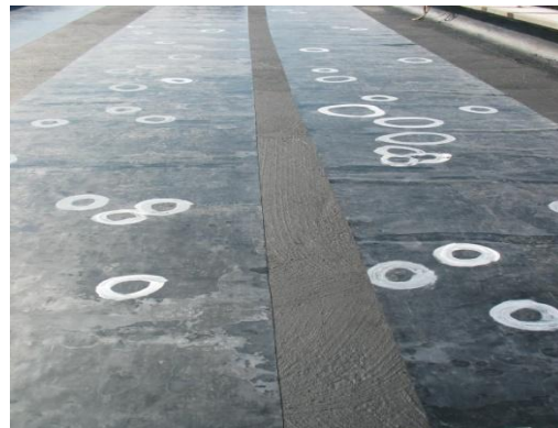
Figura 58 – Furos na manta
