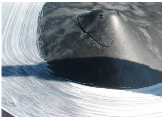
Figura 57 – Defeito da manta
