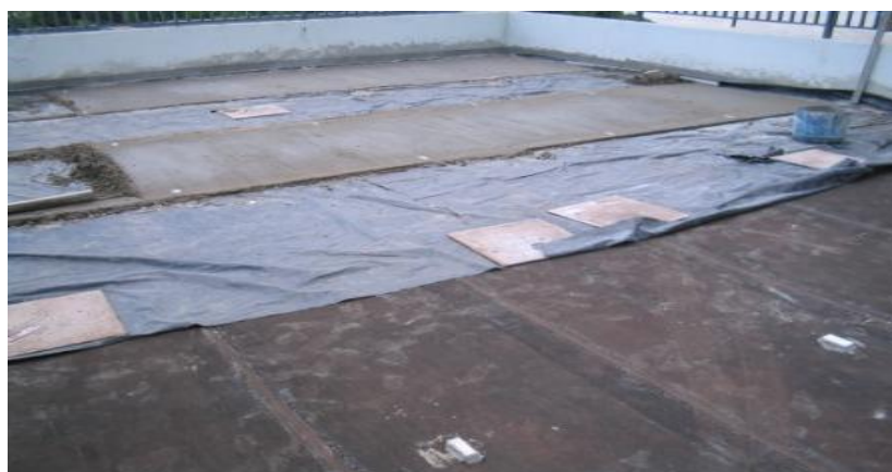
Figura 34 – Execução da camada de proteção
