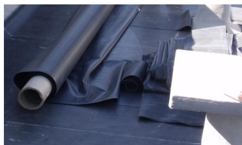
Figura 44 – Colagem da manta
