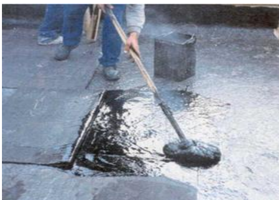
Figura 9 – Impermeabilização aplicada a quente com estruturante Fonte: Juliana Nakamura (2012)
