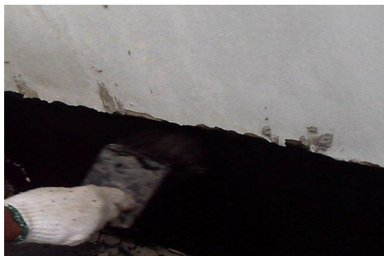
Figura 38– Encaixe da manta Fonte: VIAPOL, (2008)
