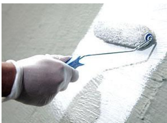
Figura 10 - Membrana acrílica Fonte: Romário Ferreira (2008)
