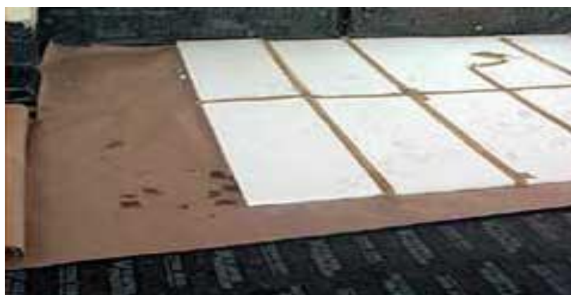
Figura 33– Camada separadora com isolante
