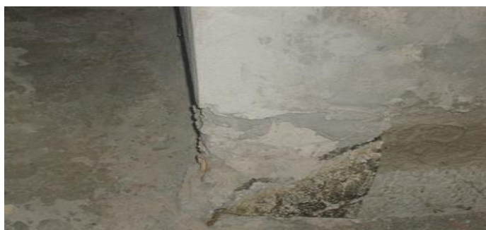
Figura 55 – Descolamento da manta
