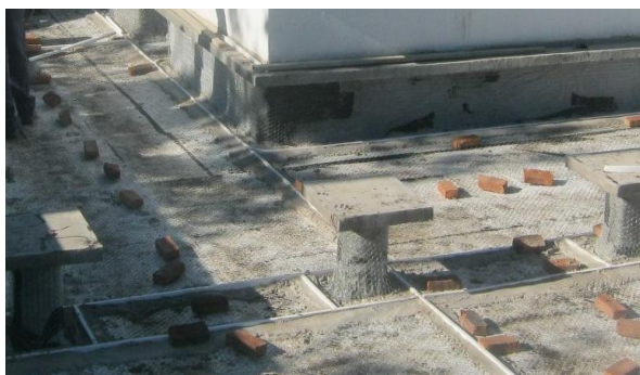
Figura 48 – Camada de proteção
