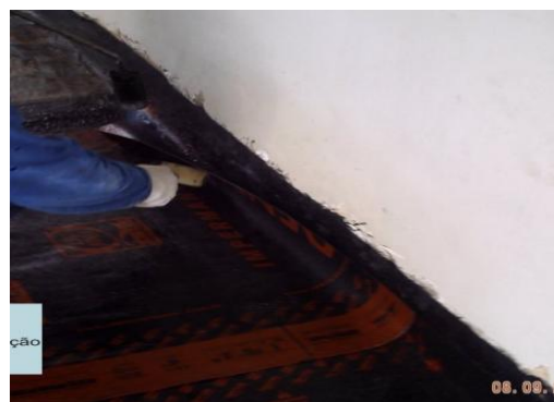
Figura 39 – Encaixe da manta no rodapé Fonte: VIAPOL, (2008)
