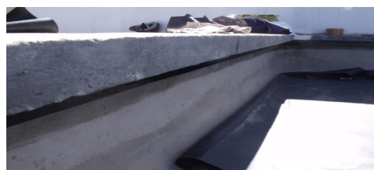
Figura 46 – Colagem da manta
