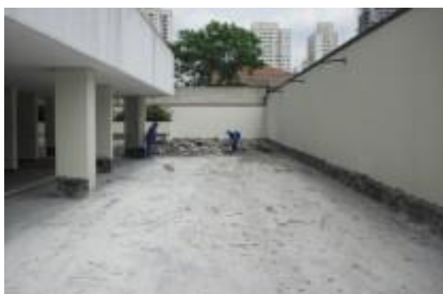
Figura 2 – Limpeza da área
