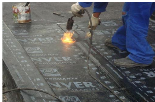
Figura 29 – Biselamento Fonte: www.primer.com.br (acesso 2/07/2012)
