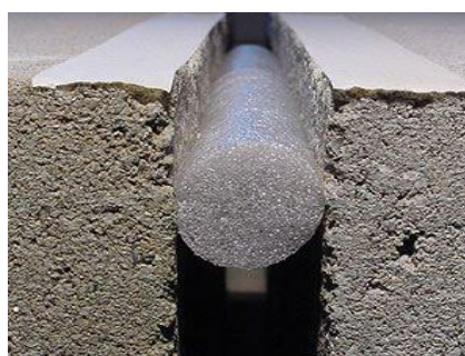
Figura 42 – Detalhe da junta Fonte: Ana Lourençon (2011)
