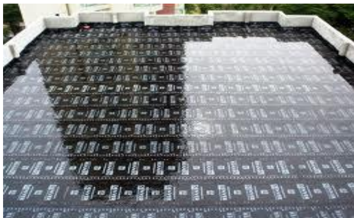
Figura 30 - Teste de estanqueidade Fonte www.igazengenharia.com.br (acesso 5/07/2012)
