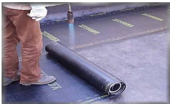
Figura 28 – Aplicação da manta Fonte: www.primer.com.br (acesso 2/07/2012)
