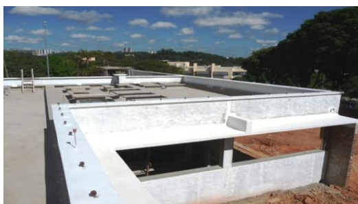
Figura 43 – Superfície regularizada
