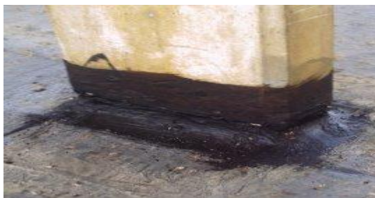
Figura 40 – Detalhe de rodapé do pilar Fonte: VIAPOL, (2008)
