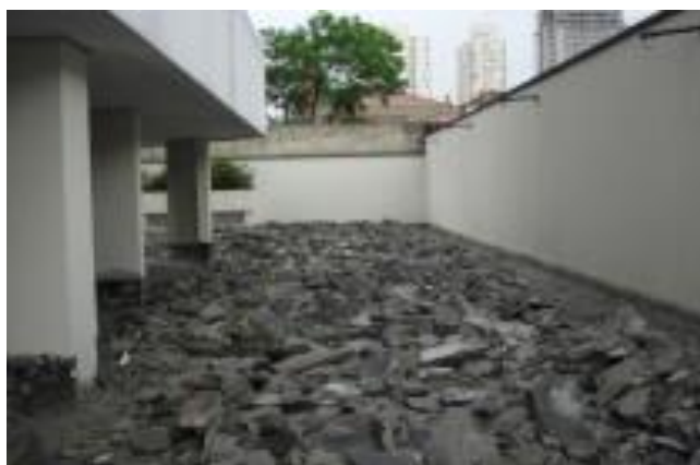
Figura 1 – Retirada de Revestimento
