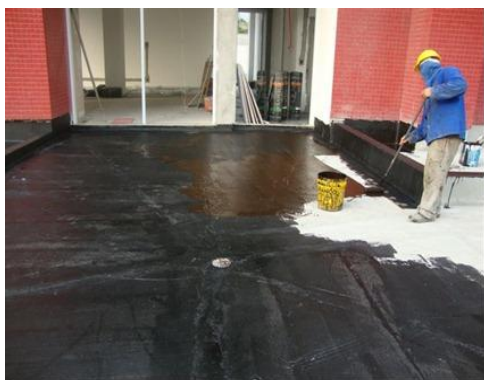
Figura 26 – Aplicação de Primer Fonte: Anuário Pini (2012)
