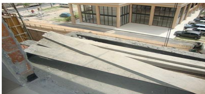
Figura 53 – Tábuas sobre a laje impermeabilizada
