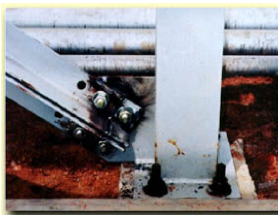
Figura 43 - Peça com comprimento menor que o necessário. – Fonte: CASTRO (1999)
