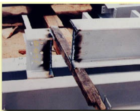
Figura 44 - Peça com comprimento maior que o necessário. – Fonte: CASTRO (1999)
