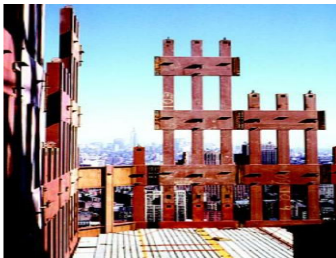
Figura 8 - Detalhe colunas de aço com 5 cm de espessura
