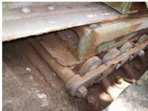
Figura 10 - Detalhe de apoio articulado
