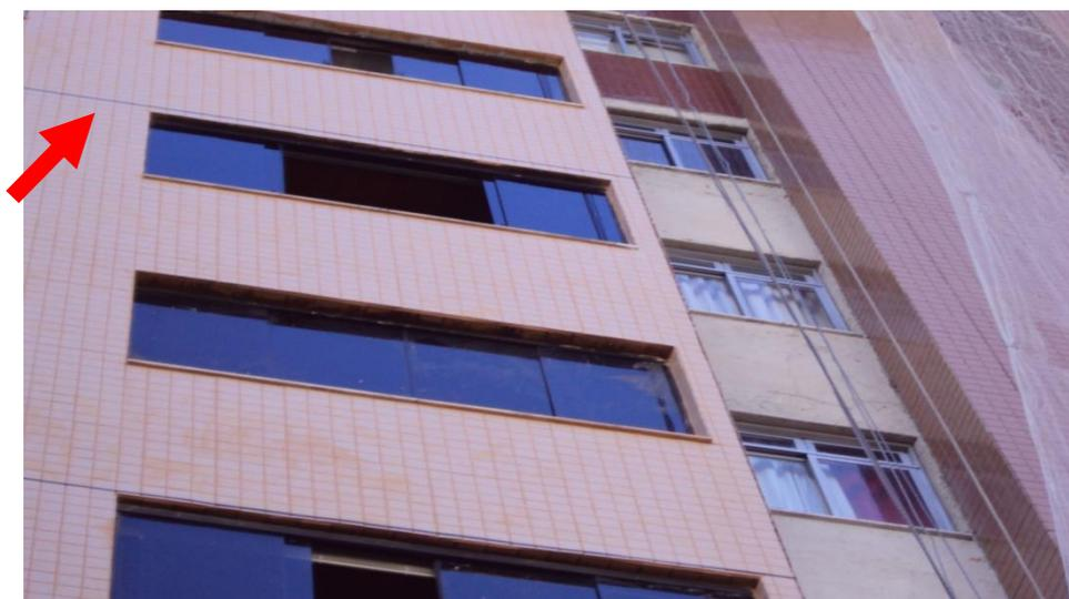
FIG 30- Parte revestida da fachada, as juntas tem a profundidade somente do revestimento cerâmico e foi selada com mastique a base de poliuretano
