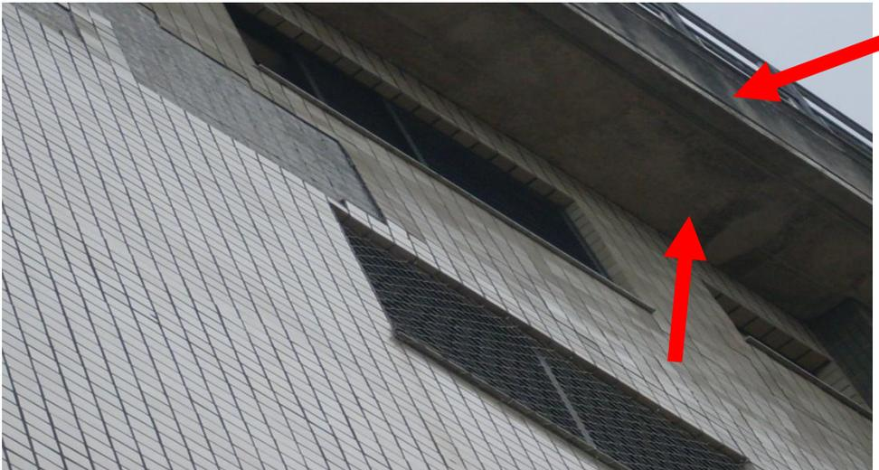
**FIG 19. Exemplo de falta de manutenção sujidade do concreto aparente**
