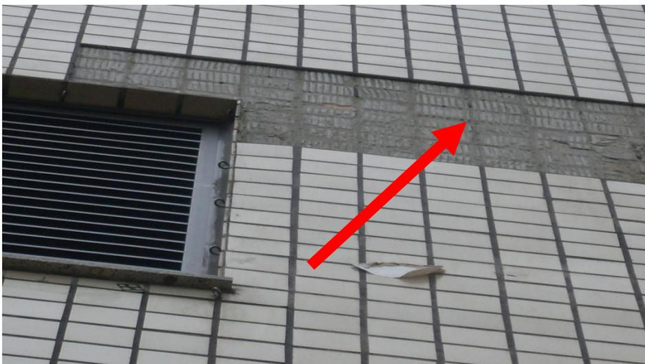
**FIG 21. Exemplo do descolamento/desplacamento e dos ganchos de rede de proteção**
