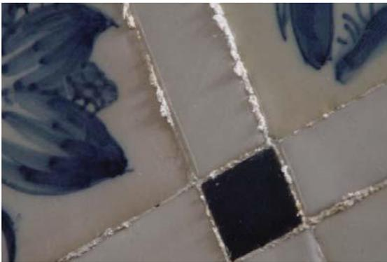
FIG.39.Exemplo da eflorescência avançada formando cristalizações nas juntas
