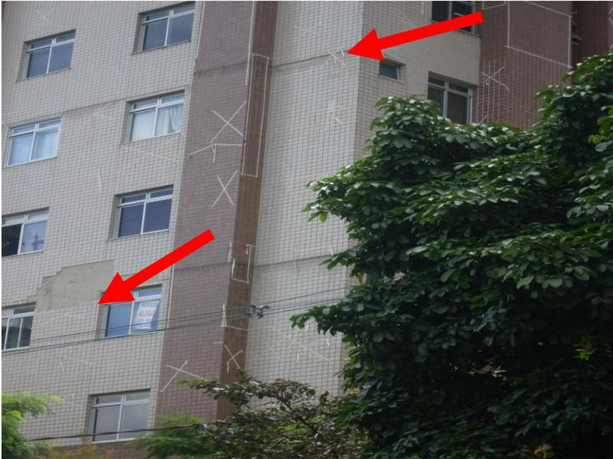
FIG 24. 1ª torre outubro de 2010 Deslocamento e estufamento do revestimento locais marcados após teste de percussão com fita crepe
