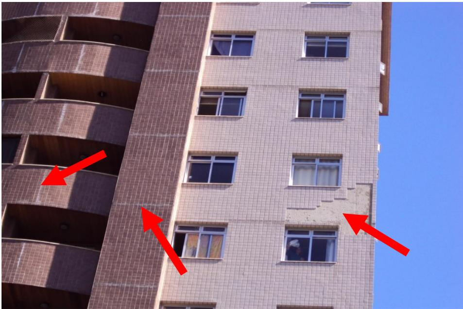
FIG 32. Eflorescência e estufamento do revestimento na posição das vigas acima das janelas , início do descolamento
