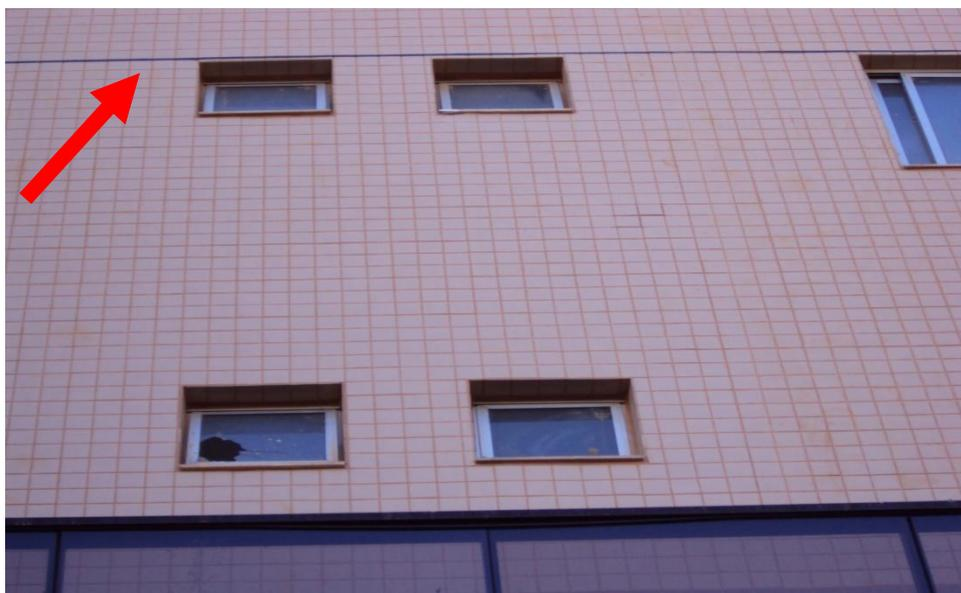
FIG. 31. Detalhe da junta executada, não houve corte no emboço
