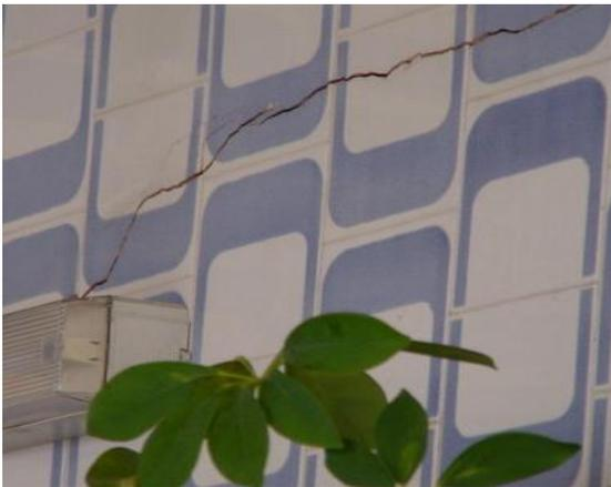
FIG. 42.Exemplo de fissuras e gretamentos em fachada dos anos 60/70, revestimento em azulejos decorados
