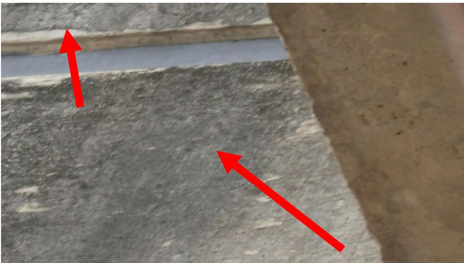
**FIG 23. Exemplo de falta de manutenção, sujidade e incrustações.**
