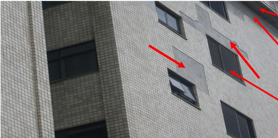
**FIG.11. 01 ano após a recuperação da fachada, começa novamente o decolamento do revestimento**
