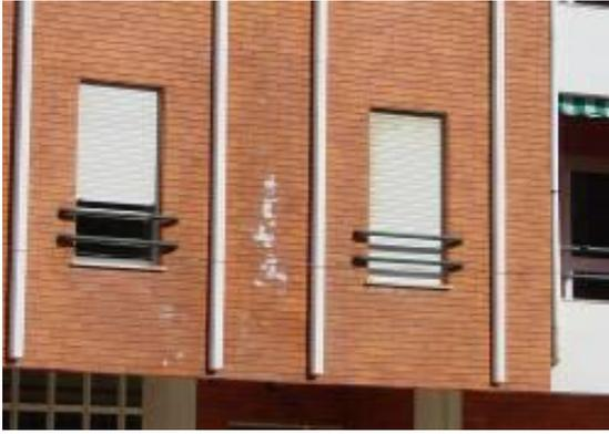
FIG.38.Exemplo de eflorescência em fachada revestida de cerâmica tipo “tijolinho”
