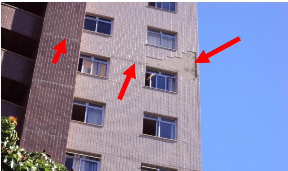
FIG.33. Eflorescência, estufamento e descolamento do revestimento
