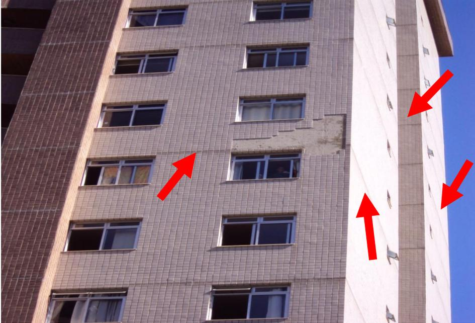
FIG.34. Detalhe do estufamento acontecendo em todas as fachadas da segunda torre
