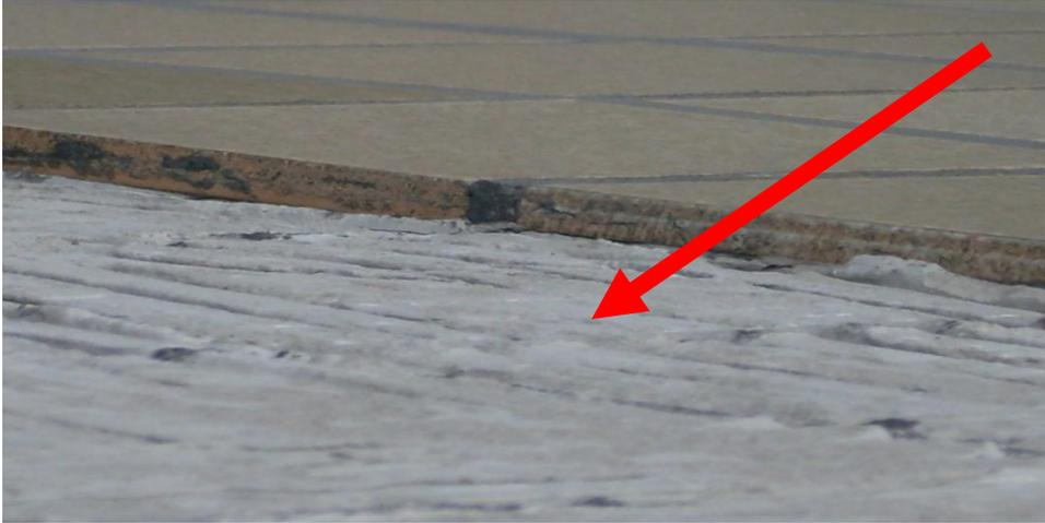
**FIG.10. Revestimento em cerâmica Portobelo 10x10, decolamento 02 anos após a entrega**
