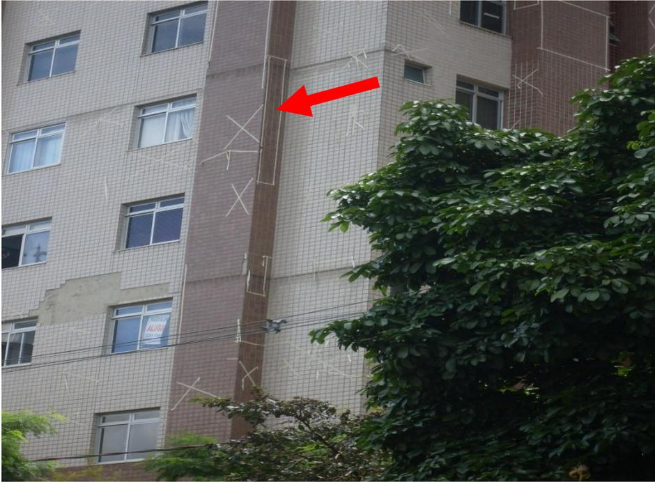
FIG 26. Deslocamento do revestimento, detalhes do teste de percussão, locais marcados com fita crepe.
