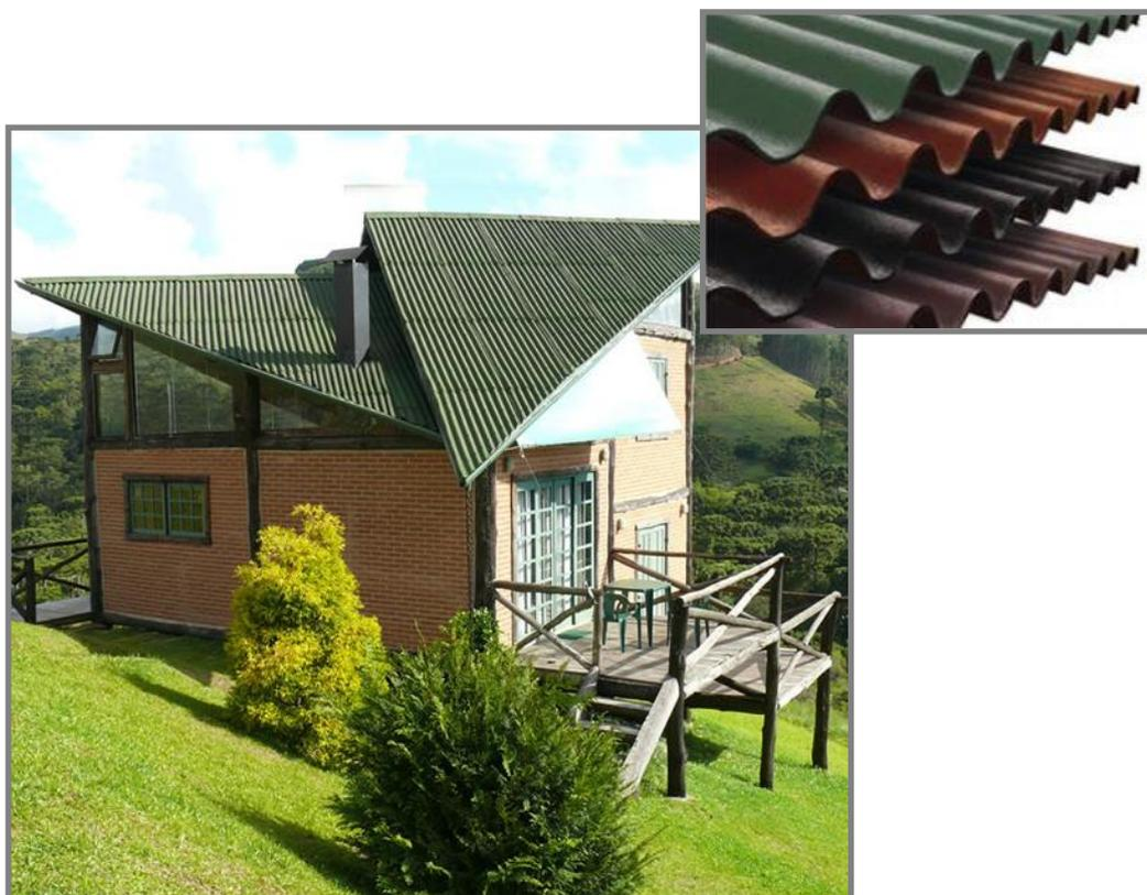
**Figura 28:** Construção com cobertura de telha de fibra vegetal.
