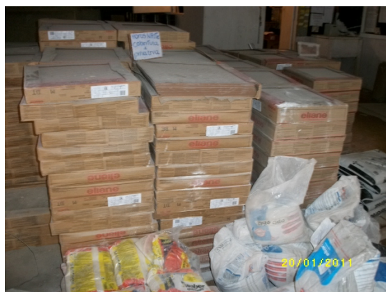
Figura 15: Armazenamento incorreto de material
