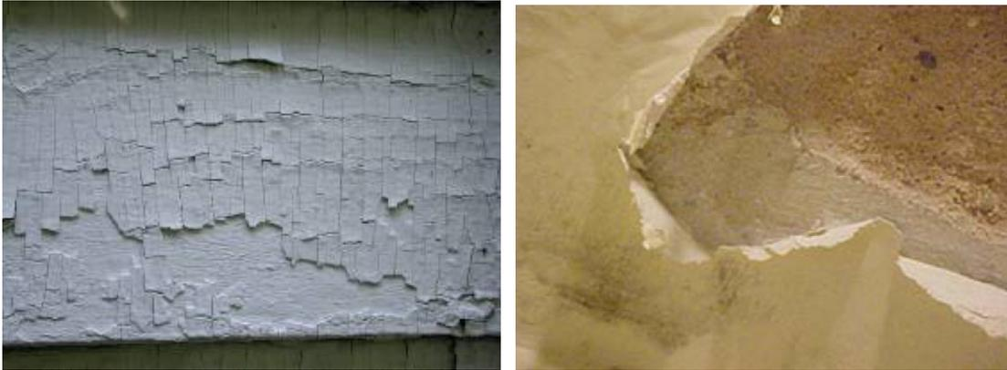
**Figura 72: Desagregação**
