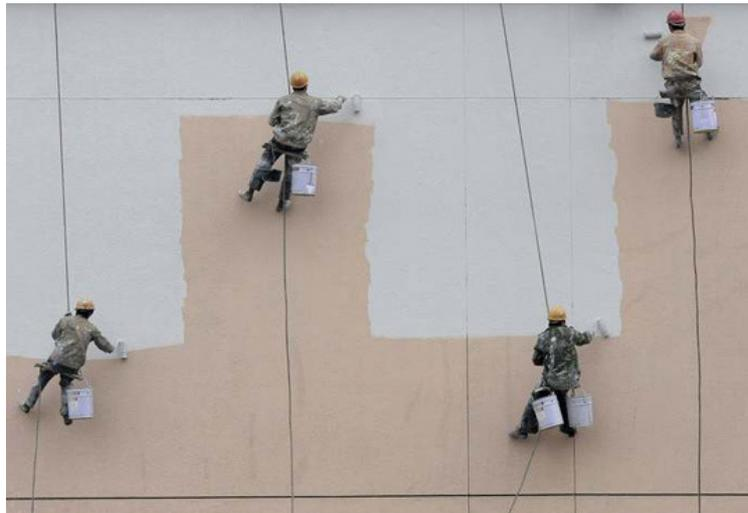
**Figura 43: Panos aplicados simultaneamente para evitar emendas**
