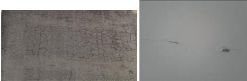
**Figura 68: Fissuras mapeadas e geométricas**
