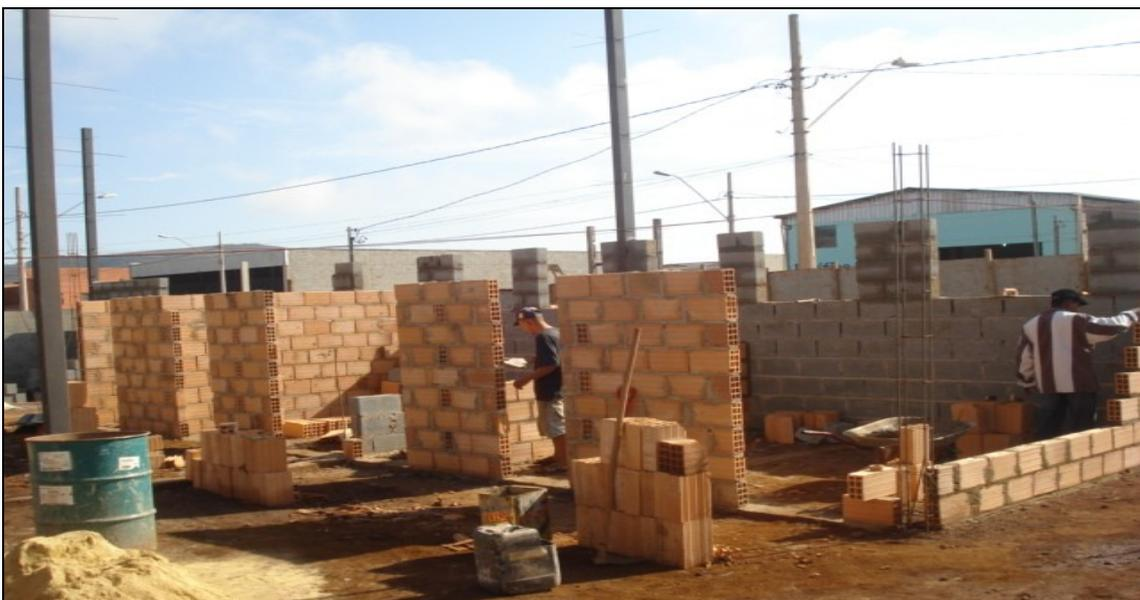
Figura 10 Alvenaria do escritório realizada por equipes diferentes. Acervo próprio
