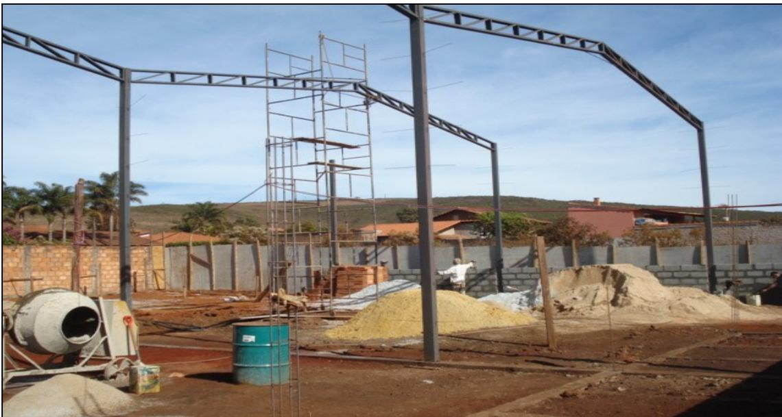
Figura 09 - Lançamento da estrutura metálica e início de alvenaria. Acervo próprio
