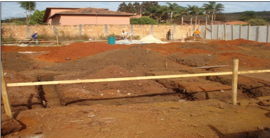
Figura 08 Após a compactação veio o excesso de terras das cintas e blocos. Acervo próprio.
