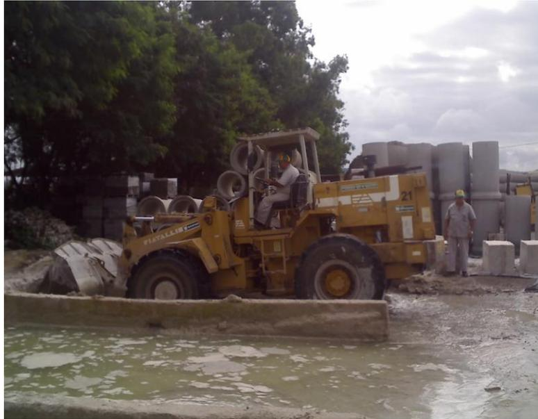
**Figura 2: Limpeza da caixa de decantação por meio de uma pá carregadeira**
