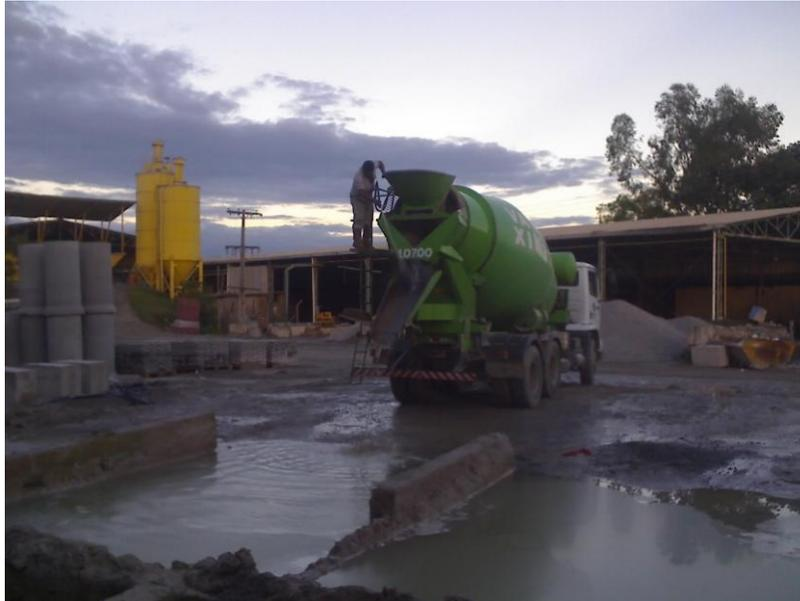
**Figura 1: Lavagem do caminhão betoneira na caixa de decantação da central de concreto da Pedreira Um Valemix de Santana do Paraíso – MG.**
