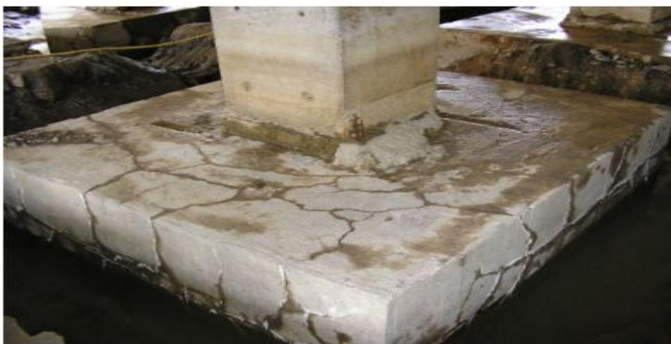
Figura 3.2. Bloco de fundação com padrão de fissuração típico de RAA (Pecchio et al., 2006).
