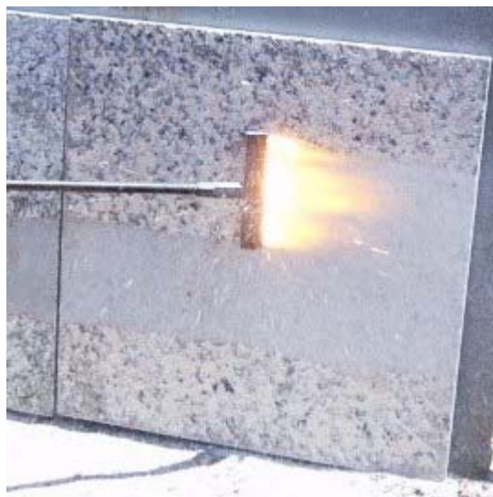
Figura 30: Técnica de flameamento.
