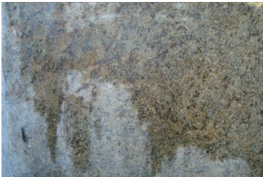
Figura 33: Chapa de granito levigado sendo passado o impermeabilizante em uma das suas superfícies.
