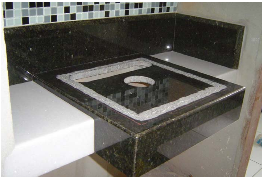
Figura 41: Bancada com furo sem a cuba colada.
