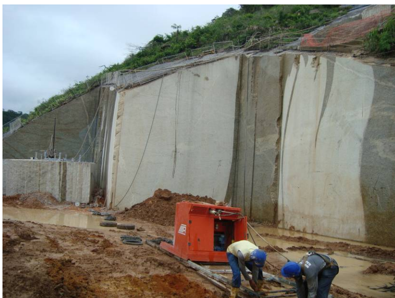
Figura 14: Vista corte da pedreira Sapucaia Castelo ES.
