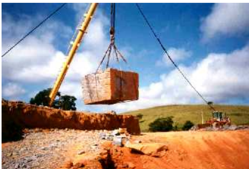
Figura 16: Bloco sendo levantado pelo "pau de carga".
