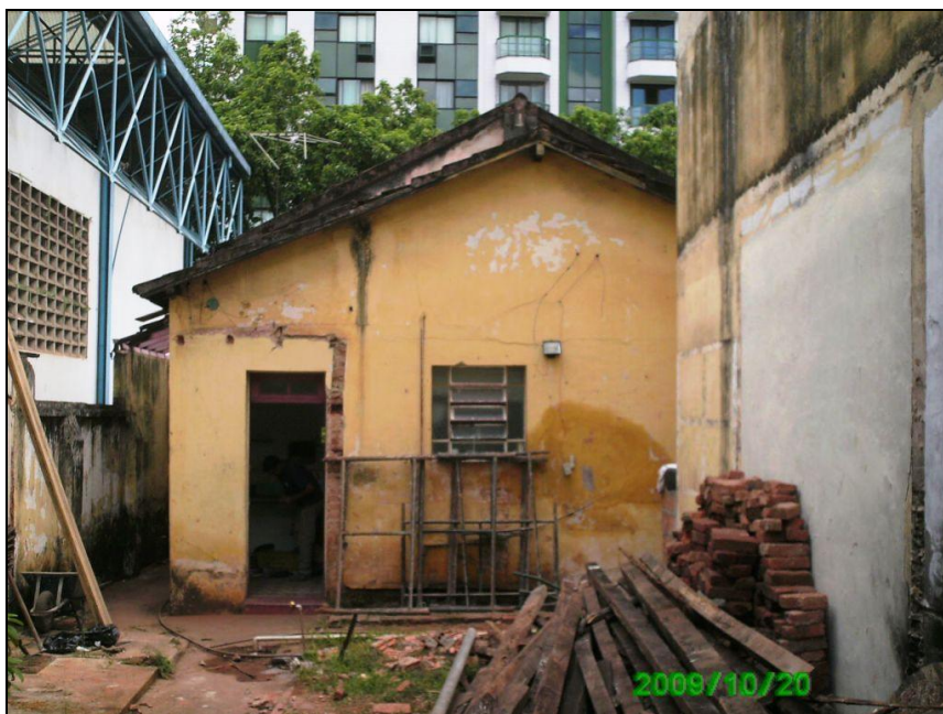
Figura 34: Vista do acesso dos fundos do imóvel antes da reforma. Setembro 2009.
