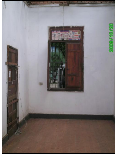
Figura 24: Vista da ante-sala antes da reforma. Setembro 2009.
