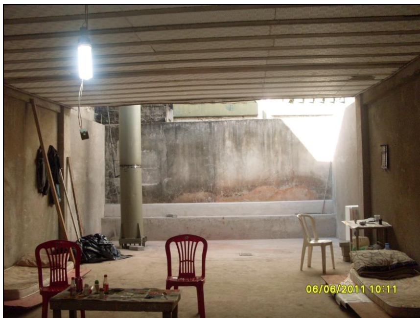
Figura 38: Vista do anexo em construção.
