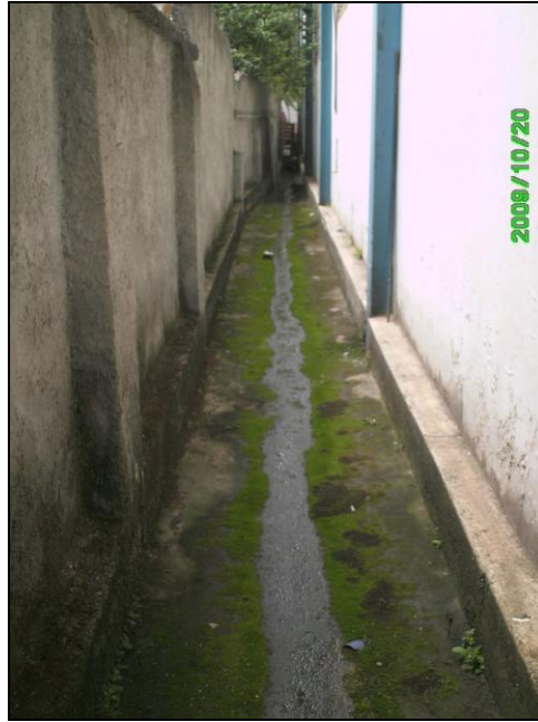
Figura 36: Vista do piso lateral antes da reforma. Setembro 2009.
