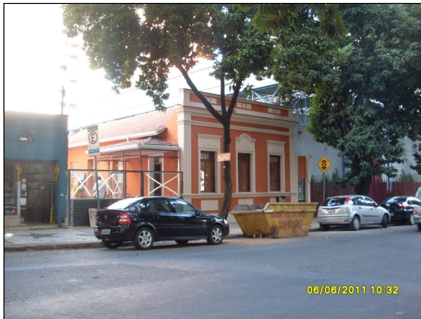
Figura 13: Vista da Rua Santa Rita Durão e o imóvel avaliando.
