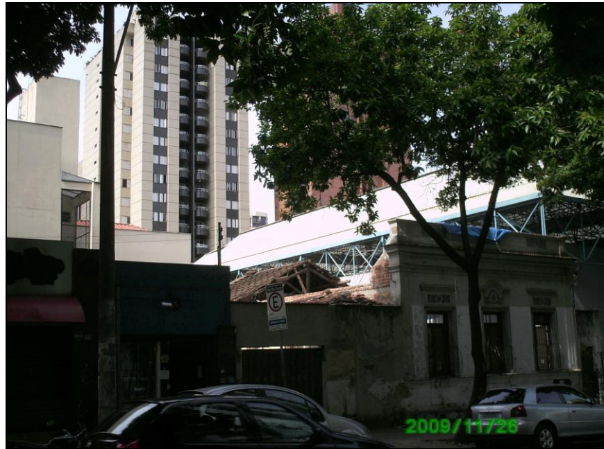
Figura 12: Vista do imóvel avaliando antes da restauração. Novembro 2009.
