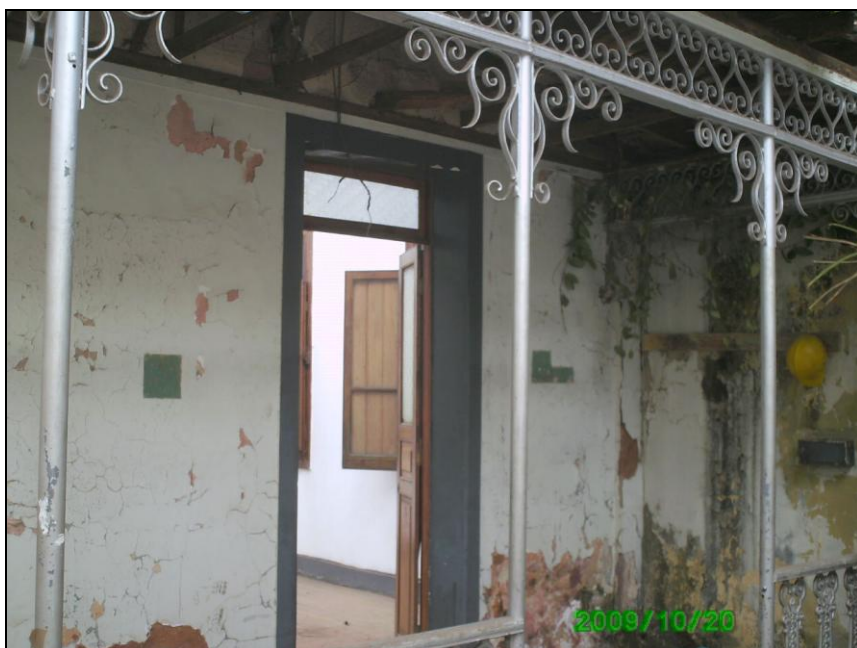
Figura 16: Vista da varanda de acesso principal antes da reforma da serralheria. Setembro 2009.
