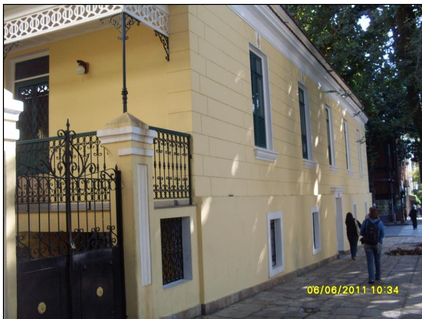
Figura 07: Imóvel semelhante (imóvel A) encontrado na Rua Cláudio Manoel com Pernambuco – Funcionários.
