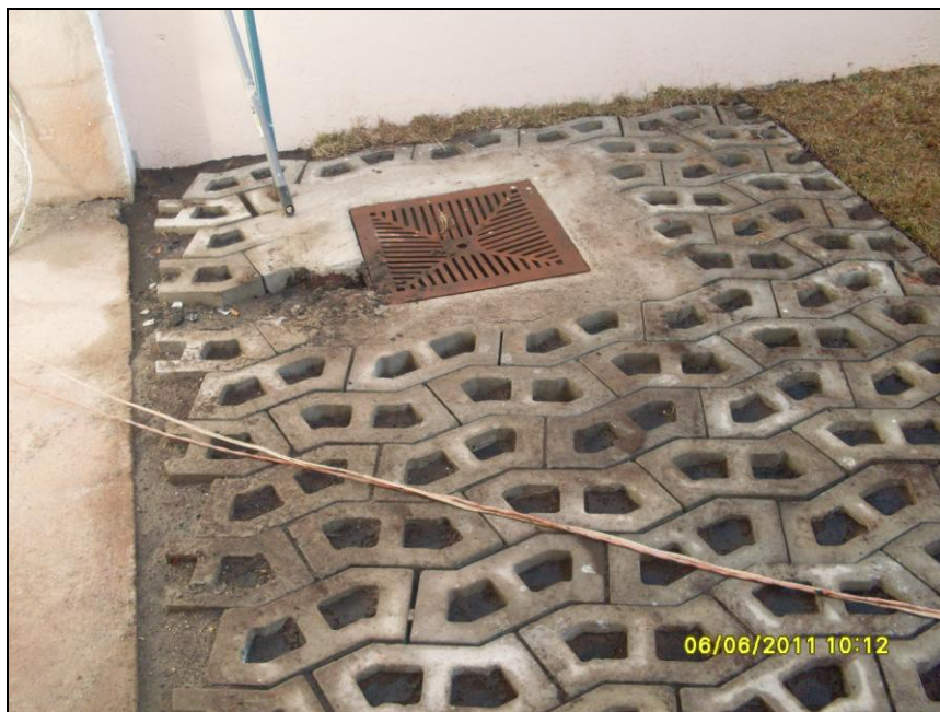
Figura 37: Vista do piso permeável e do jardim dos fundos.
