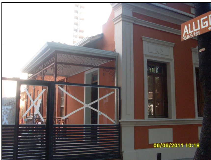
Figura 15: Vista do acesso principal ao imóvel com a esquadria dividida em acesso de veículos e pedestres.
