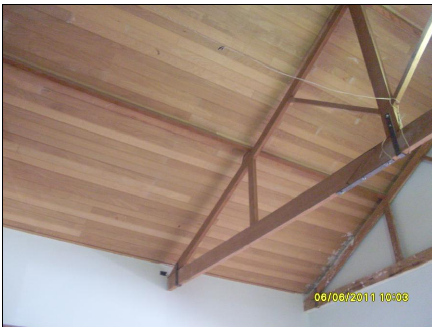
Figura 33: Vista do forro de madeira reformulado.
