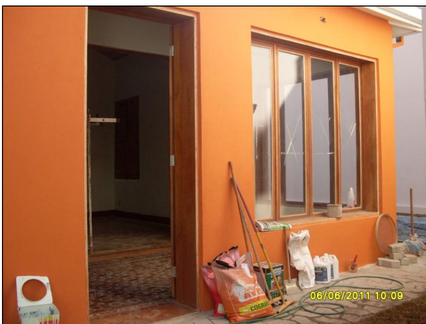
Figura 35: Vista do acesso do imóvel após a reforma.
