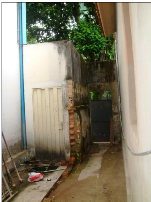
Figura 14: Vista do Gradil antes da reforma, Setembro 2009.
