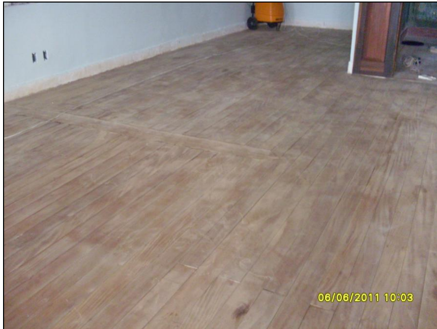
Figura 28: Vista do piso em madeira restaurado.
