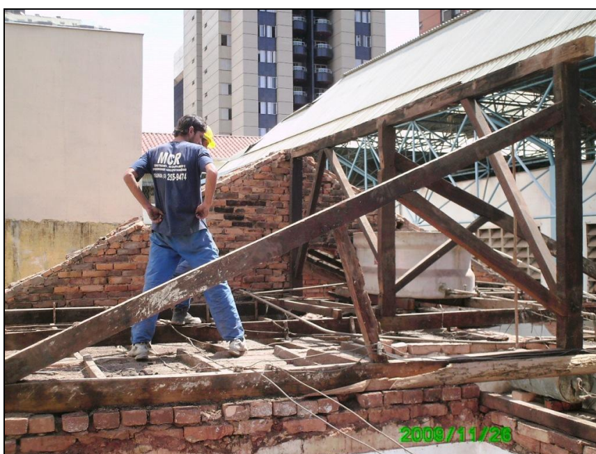
Figura 31: Vista do telhado em processo de recuperação. Novembro 2009.
