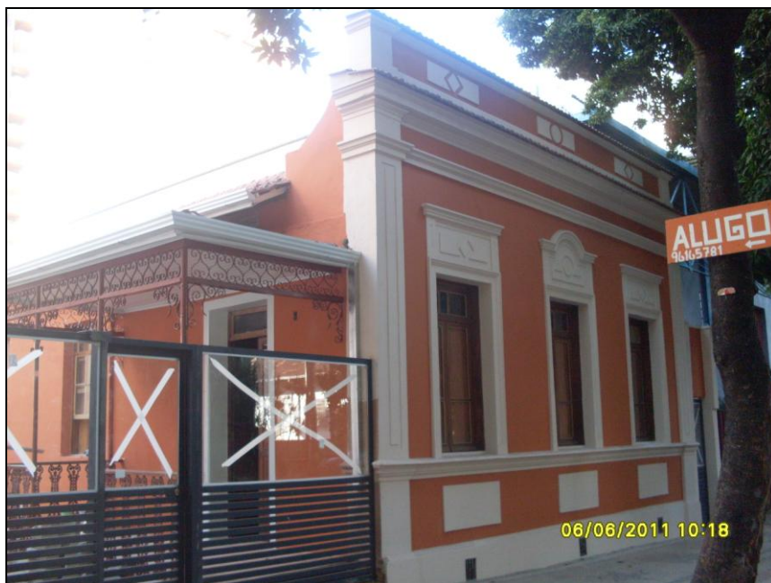
Figura 09: Vista Frontal do imóvel avaliando, localizado na Rua Santa Rita Durão, 999 - Funcionários.
