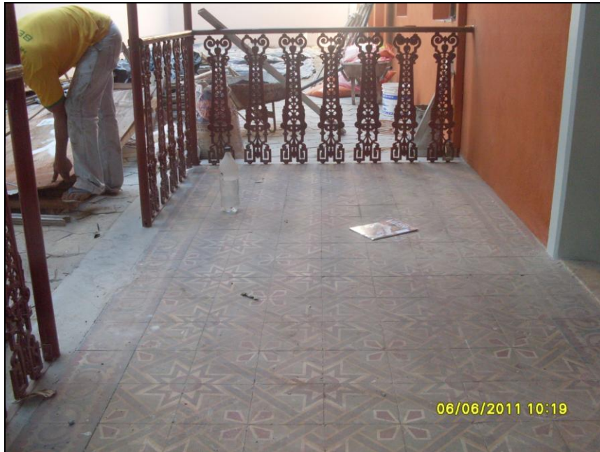
Figura 18: Vista da serralheria reformada e do piso em ladrilho hidráulico recuperado.
