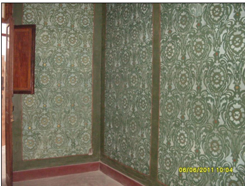
Figura 21: Vista da pintura da ante-sala retocada.
