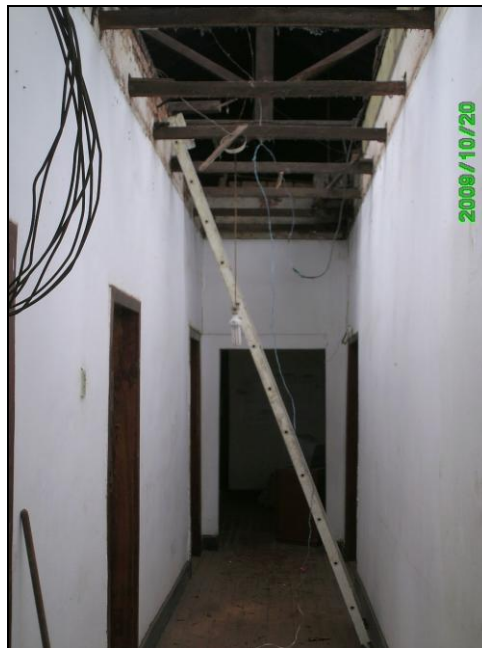
Figura 23: Vista da paredes internas ainda não demolidas. Setembro 2009.
