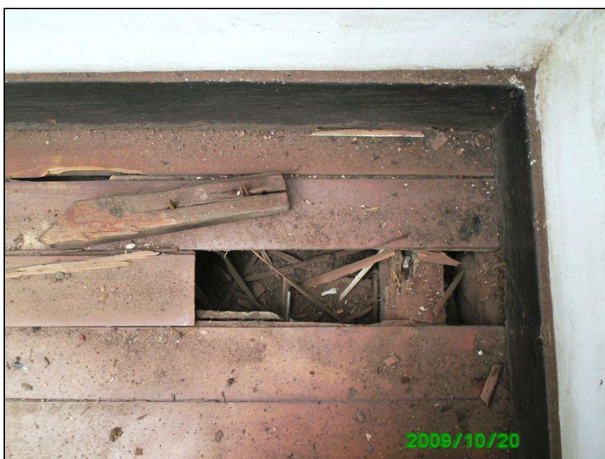
Figura 27: Vista do piso em madeira antes da recuperação. Setembro 2009.
