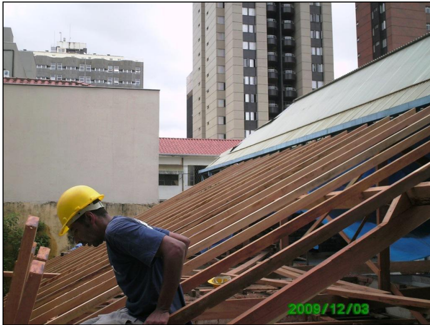
Figura 32: Vista do telhado em processo de recuperação. Novembro 2009.
