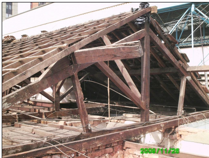
Figura 29: Vista do telhado em processo de recuperação. Novembro 2009.
