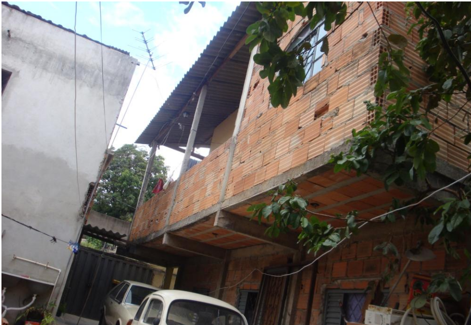
Fotografia 04 – Fachada lateral esquerda benfeitorias 01 e 02
