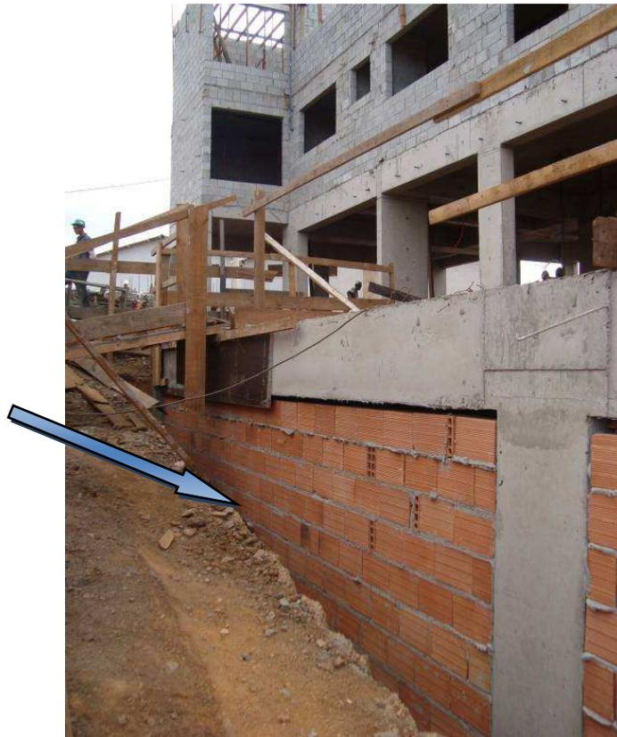
Figura 06: Distância entre a Contenção e a Edificação - Obra Estudada
