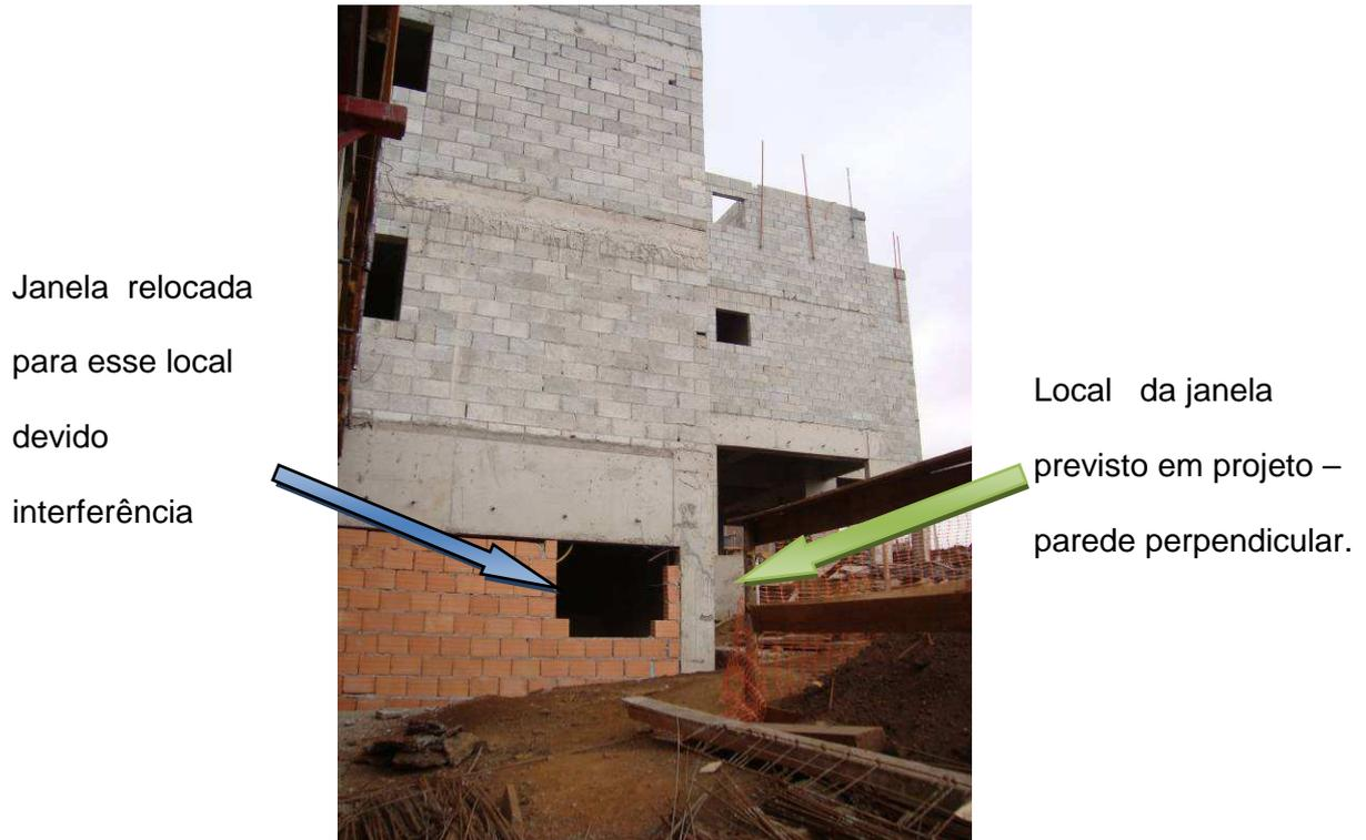
Figura 04: Edifício em Alvenaria Estrutural - Obra estudada
