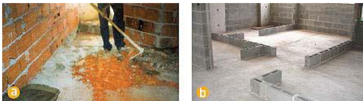
Figura 5.4 Alvenaria de vedação: a) tradicional - desperdício, sujeira e tijolos assentados quebrados; b) racionalizada - organização e redução de perdas e de consumo (JÚNIOR e NEVES, 2009)
