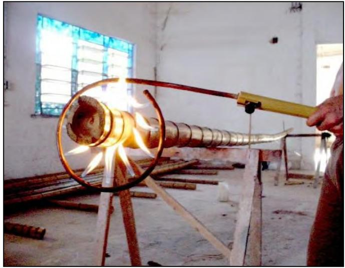
Figura 15: Cura do bambu por aquecimento (Fonte: Nunes, 2005).
