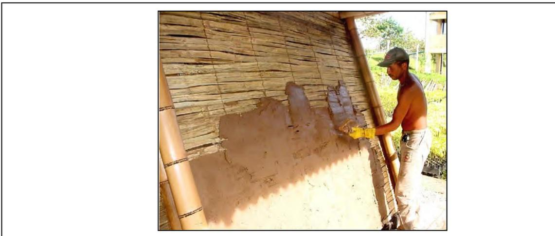
Figura 38: Parede de esterilha (Fonte: Nunes 2005)
