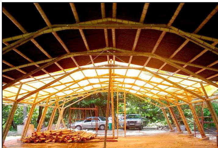
Figura 36: Telhado com bambu roliço e telha ecológica (Fonte: Nunes, 2005)
