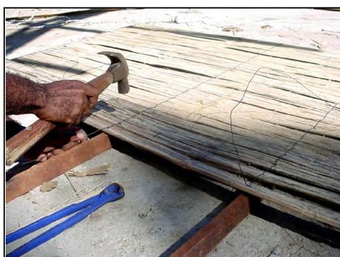
Figura 31: Esterilhas sendo presas na grade de madeira com auxílio de pregos e arame recozido (Fonte: Nunes, 2005)
