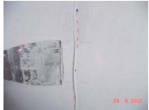
Figura 4.2 - Preenchimento das fissuras com argamassa aditivada (Fonte: Max Junginger)
