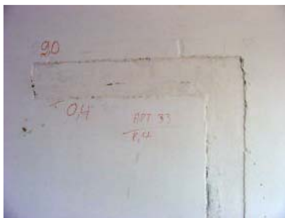
Figura 3.92 - Regularização do substrato
