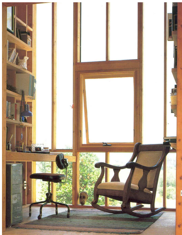
Figura 03 – Janelas basculantes seleciona a quantidade de ventilação necessária para o ambiente sem interferirem com a luminosidade do local
