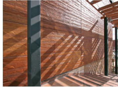
Foto 2.24: exemplo de texturas a partir de fôrmas com relevos no padrão madeira, aplicado em fachada – nawkaw
