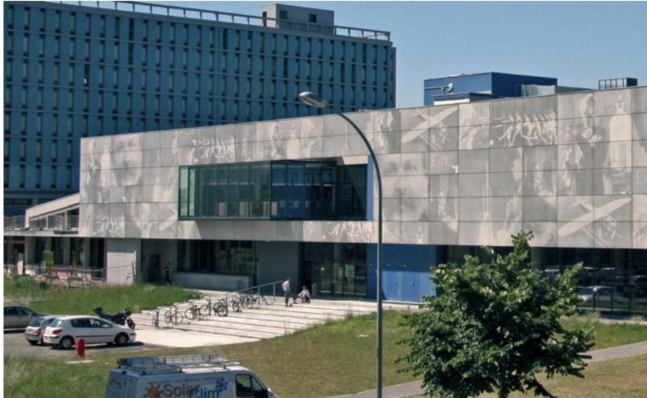
Foto 2.32: Universidade Paul Sabatier, Toulouse, arquitetura Agência Espagno & Milani - fachada modulada -concreto fotogravado - RECKLI®-Formliner sistema - painéis 2,40 m x 1,20 m, efeito de colagem. Fonte: [http://www.nawkaw.com/formliners/1143\\_Fotobeton\\_Toulouse.pdf](http://www.nawkaw.com/formliners/1143_Fotobeton_Toulouse.pdf).
