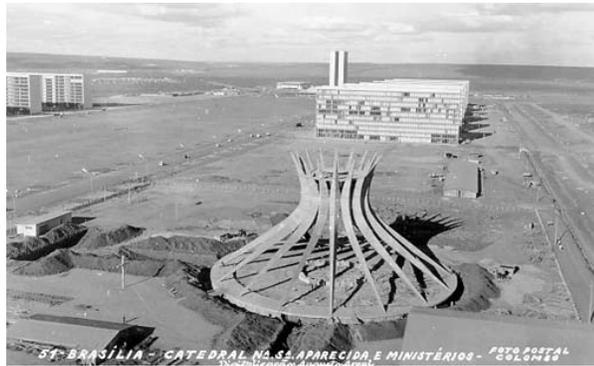
Foto 2.15: Construção de Brasília, projeto urbanístico de Lúcio Costa e, Catedral - estrutura em concreto armado, construída em 1960, projeto estrutural de Joaquim Cardozo e arquitetônico de Oscar Niemeyer - que utiliza o concreto armado como matéria básica de suas obras explorando sua plasticidade. Fonte: <http://ultimaparada.wordpress.com/2009/04/21/brasilia-49-anos-imagens-da-construcao/>
