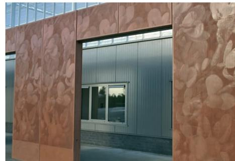
Foto 2.33/2.34: alicação de figuras - técnica que utiliza sistema de fôrma em baixo relevo - RECKLI®-Formliner sistema.
