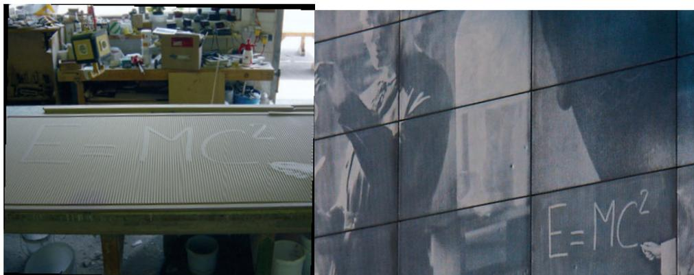
Foto 2.30/2.31: Edifício Universidade Paul Sabatier, Toulouse, Arquit. Agência Espagno & Milani – concreto fotografado detalhe fachada- processo de fotogração, RECKLI®-Formliner sistema – molde e fachada. Fonte: [http://www.nawkaw.com/formliners/1143\\_Fotobeton\\_Toulouse.pdf](http://www.nawkaw.com/formliners/1143_Fotobeton_Toulouse.pdf)
