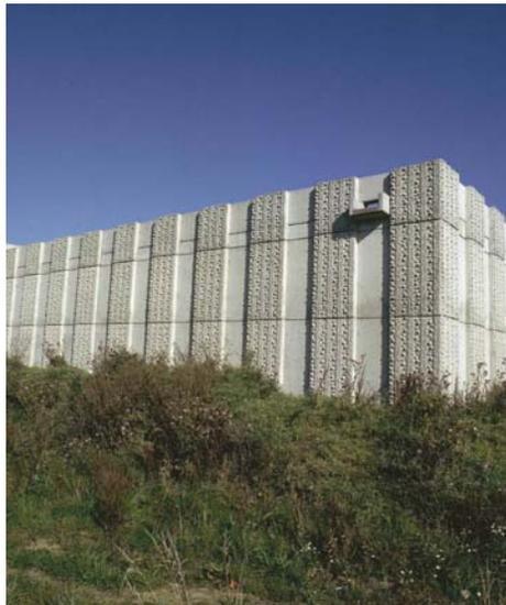
Foto 2.25: exemplo de texturas a partir de fôrmas com relevos combinada com concreto liso, aplicado em fachada - nawkaw
