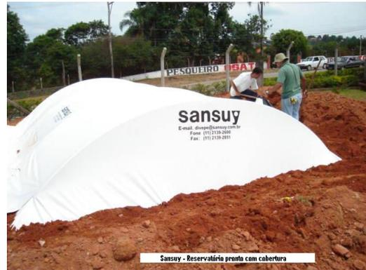
Anexo 03: Reservatório em cava no solo recoberto com PEAD ou Vinil a ser totalmente coberto com estrutura e vinil evitando luz solar (proteção contra algas) - Pode existir uma cobertura de vinil cobrindo todo canal acima desde que tenha no máximo 10m de largura, comprimento indeterminado, para evitar luz solar.
