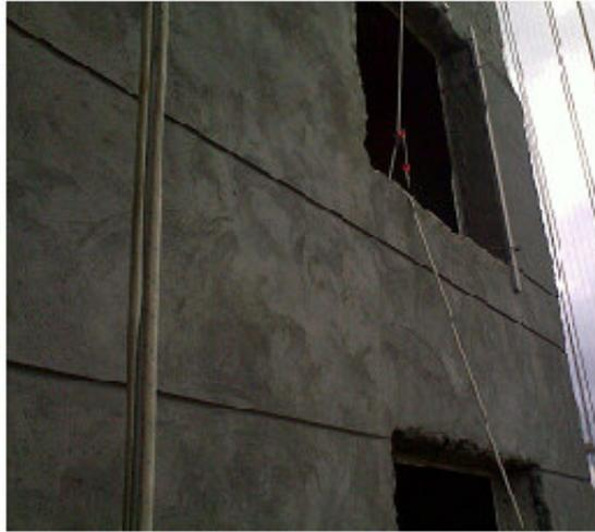
**Foto 2:** Vista parcial dos frisos da fachada, executadas com régua de alumínio e frisador, desenvolvidos em conformidade com o projeto de frisos apresentado no projeto de detalhamento das fachadas
