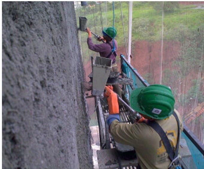
**Foto 3:** Execução de reboco com sistema de projeção em canecas.
