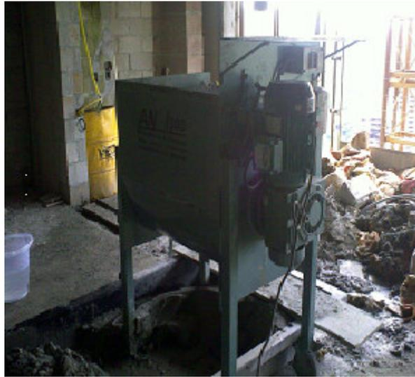
**Foto 8:** Detalhe das argamassadeiras com dosador de água, dispostas a cada três andares da edificação.
