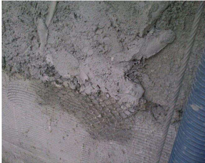
**Foto 4:** Detalhe da tela metálica utilizada entre a alvenaria e a estrutura.
