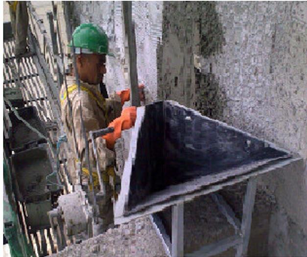
**Foto 6:** Detalhe dos funis aonde são conectados os dutos de transporte vertical
