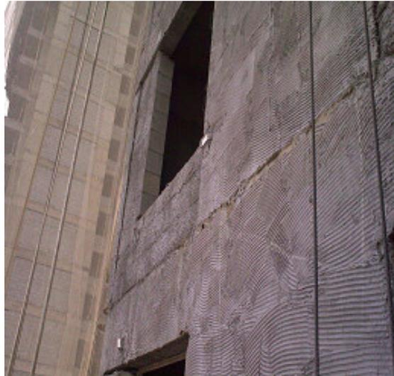
**Foto 7:** Detalhe do chapisco colante aplicado na estrutura e argamassa de projeção na alvenaria.
