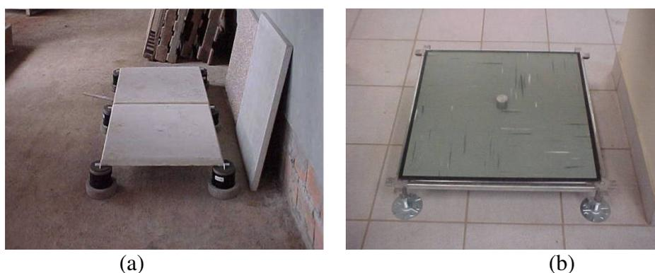
Figura 3.9 (a) Piso elevado sobre apoios de concreto ou plástico; (b) piso elevado sobre estrutura auxiliar metálica.
