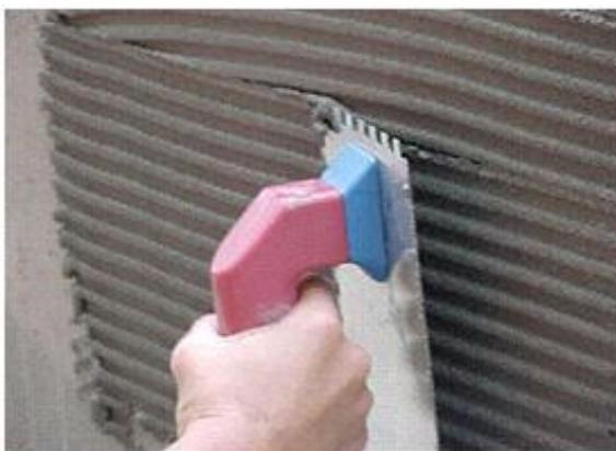
Figura 4.16 Argamassa colante ACIII, fabricante Precon.
