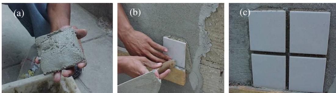
Figura 3.10 Aplicação de assentamento em “camada espessa”.
