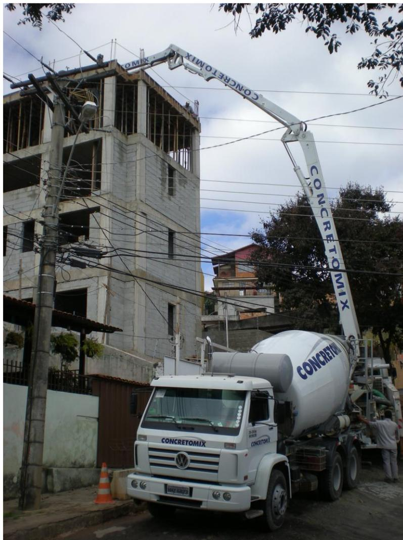
**FIGURA 3.1 - Edifício Residencial em construção, concretagem da laje do 5.º Pavimento, dos 8 pavimentos previstos.**
