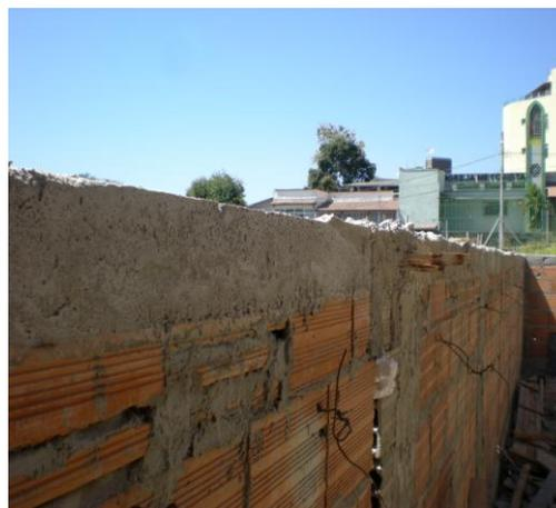
**FIGURA 3.16 - Viga de travamento de guarda corpo de alvenaria feitos com concreto com agregados de materiais Classe A reciclados.**
