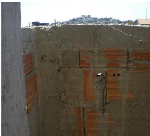
**FIGURA 3.15 – Pilarete e viga de travamento de guarda corpo de alvenaria feitos com concreto com agregados de materiais Classe A reciclados.**
