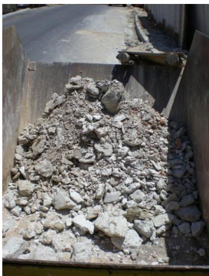
**FIGURA 3.24 – Materiais Classe C (Gesso) armazenados em caçamba separada.**
