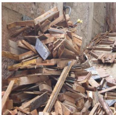
**FIGURA 3.21 – Materiais Classe B (Madeiras) limpas e armazenadas para reuso.**
