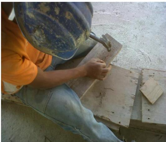
**FIGURA 3.19 – Processo de pregos sendo desamassados.**
