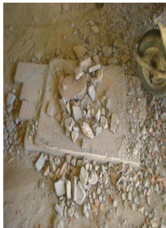
**FIGURA 3.11 – Plataforma de madeira para compactação resíduos.**
