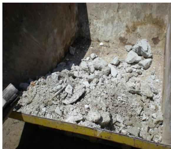
**FIGURA 3.25 Materiais Classe C (Gesso) armazenados em caçamba separada.**
