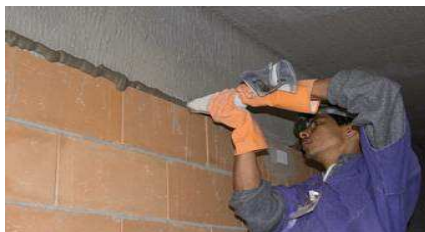
Fig.2 “Encunhamento com massa forte com expansor”.
