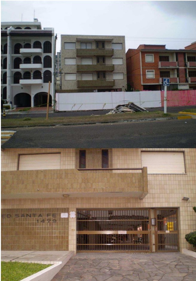
Fig. 10 “Foto do prédio a ser analisado no estudo de caso”.
