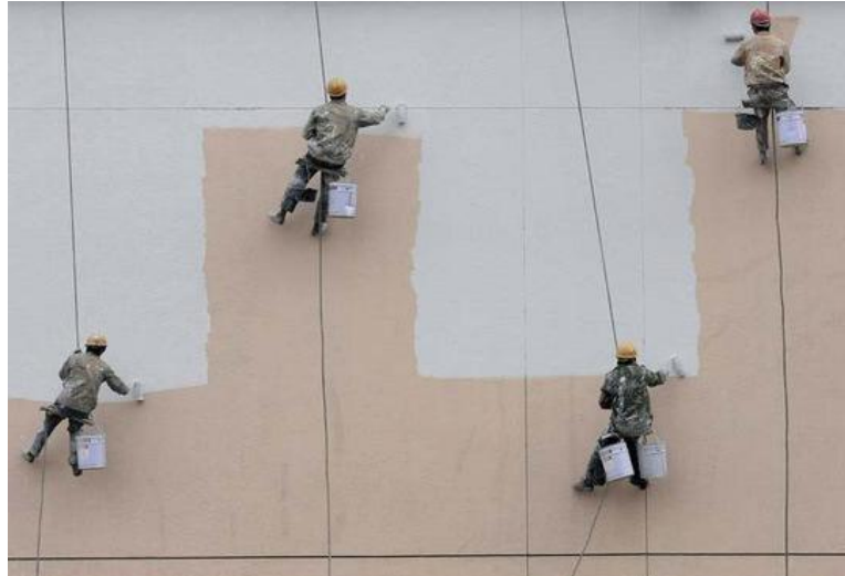
Figura 33: Panos aplicados simultaneamente para evitar emendas
