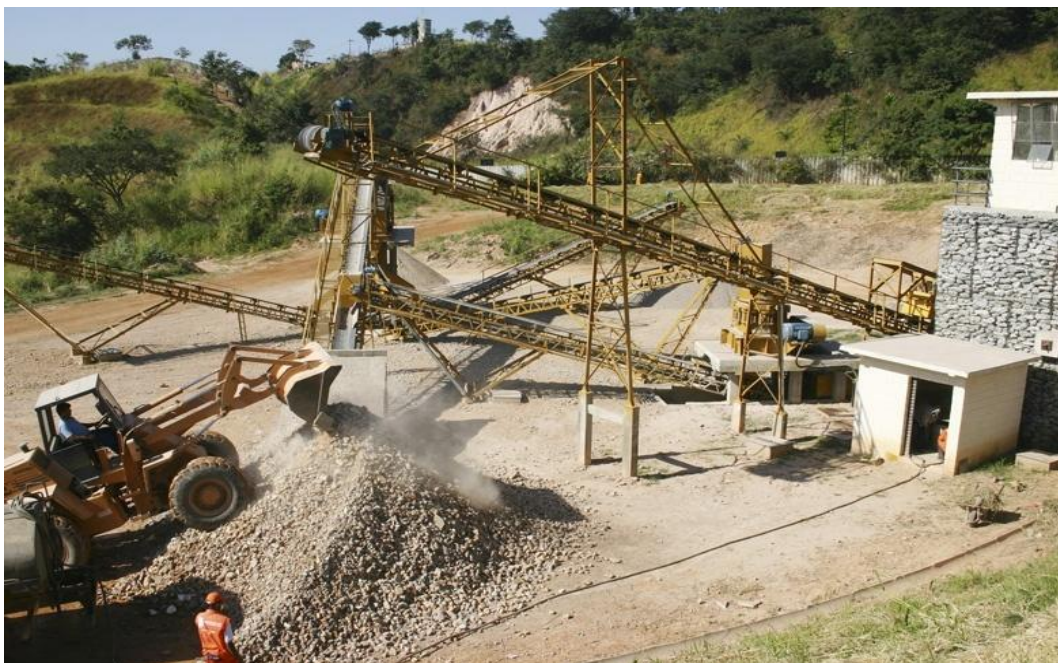
Figura 3: Estação para reciclagem de resíduos localizada em Belo Horizonte (Bairro Estoril)
