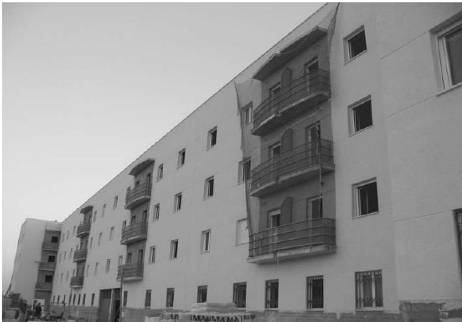
Figura 5: Construção de habitação onde foi aplicado o modelo de quantificação
