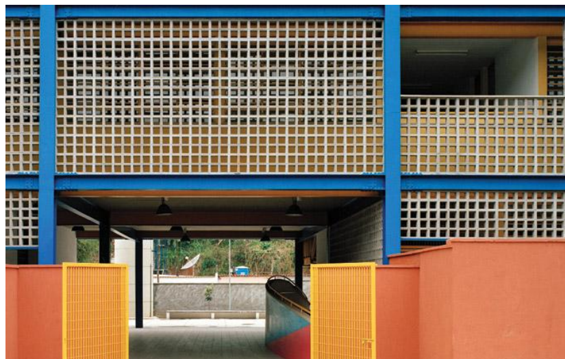
FIGURA 27 - Grelha de concreto substituindo brise tradicional Fonte: CONSTRUTORA ITAJAI, 2011
