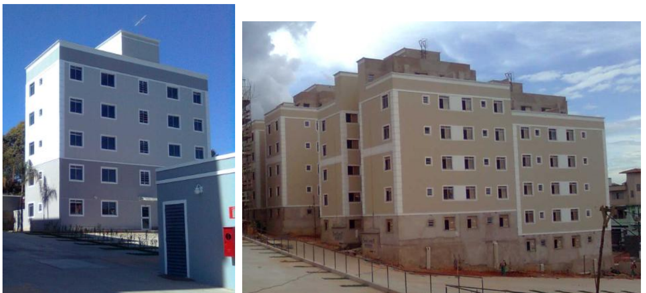
Figura 5 – Exemplos de uso de textura em revestimento de fachada de edifícios da MRV Engenharia com acabamento popular na Zona Norte de Belo Horizonte/MG. (Arquivo Pessoal – 2010)
