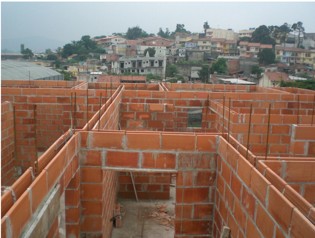
Foto 12: Parte da alvenaria estrutural executada em ponto de laje
