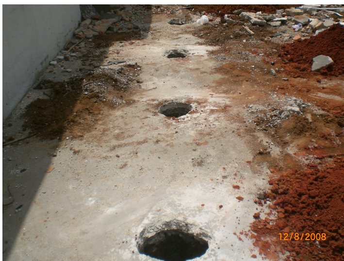
Foto 6: Brocas para sapata corrida
