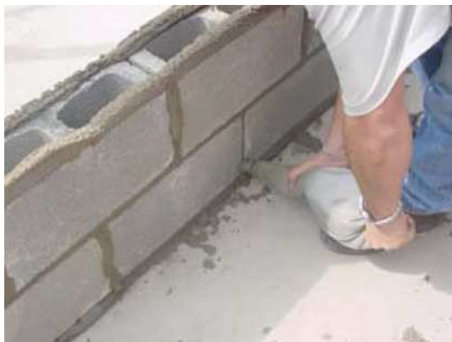
Foto 8: Aplicação da argamassa
