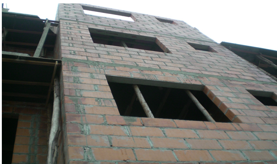
Foto 11: Parte da alvenaria executada
