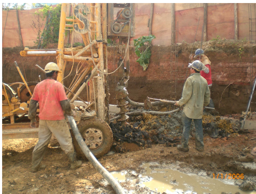
Foto 10: Perfuração hélice contínua
