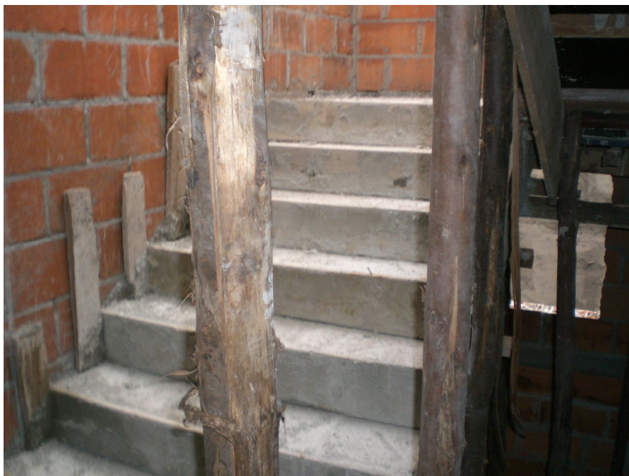
Foto 14: Escada fundida no local em concreto armado
