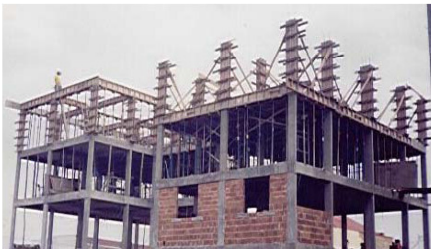
Foto 13: Edifício em concreto armado
