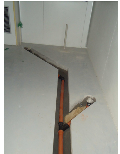
Figura 3.7: Reparo dos drens
