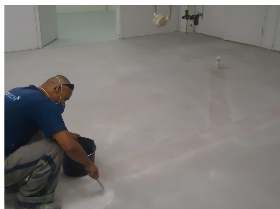
Figura 3.11: Recuperação piso – preparo para pintura epóxi.
