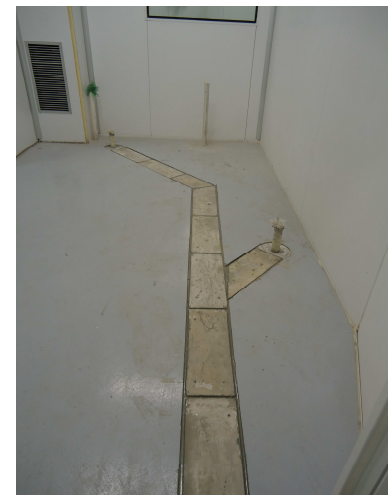
Figura 3.10: Fixação lateral com resina epóxi.
