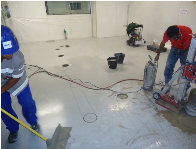
Figura 3.6: Procedimento inicial de corte do piso
