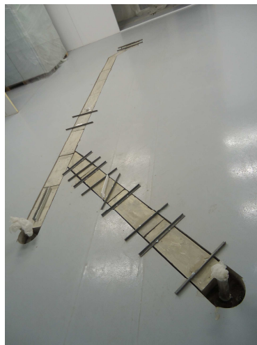
Figura 3.9: Uso de barras niveladoras para assentamento das peças
