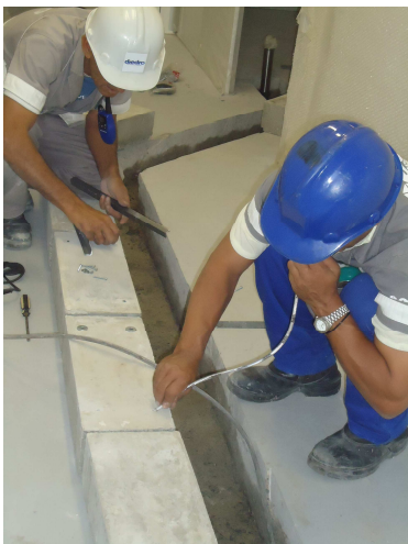
Figura 3.8.: Preparo das peças pré moldadas para assentamento
