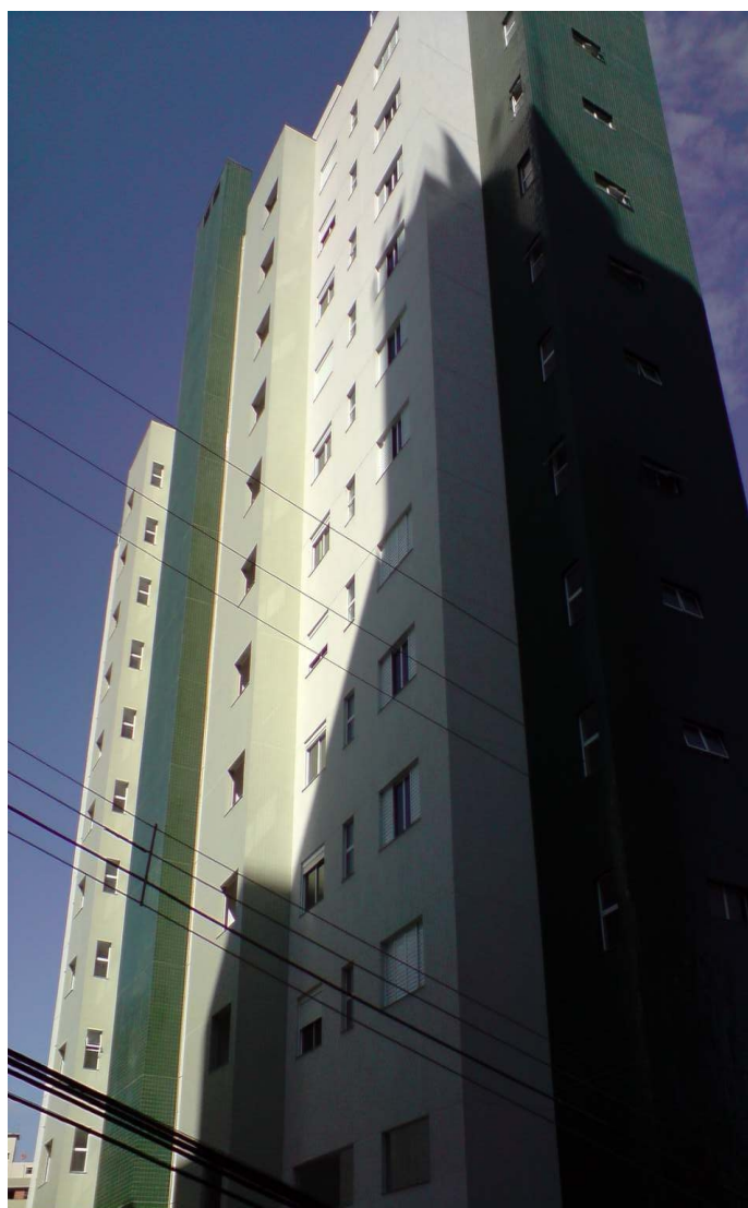
Figura 7 – Foto da fachada (arquivo do autor, 2012)
