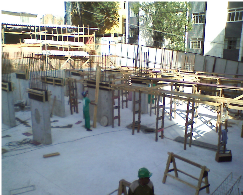
Figura 2 – Foto da montagem da 1ª laje (arquivo do autor, 2012)
