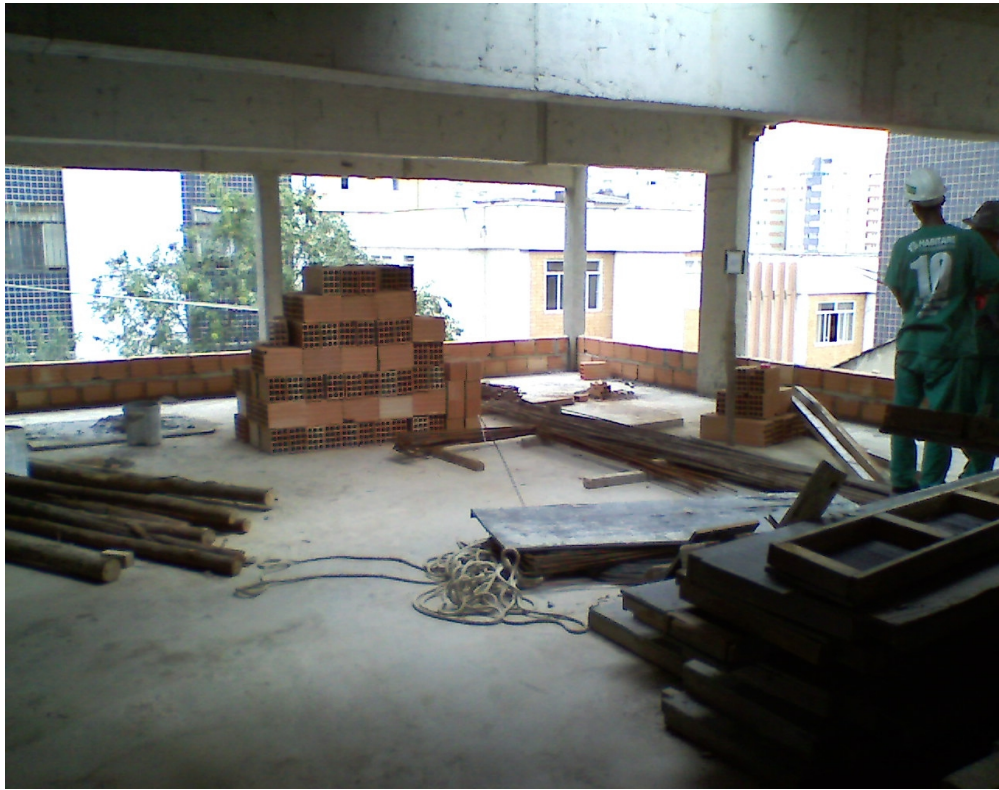
Figura 3 – Foto do início da alvenaria (arquivo do autor, 2012)
