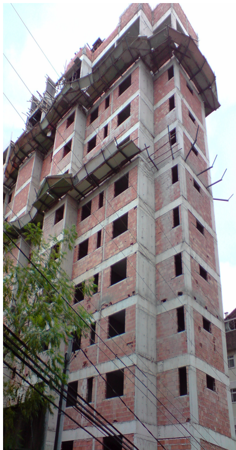
Figura 6 – Foto da fachada (arquivo do autor, 2012)
