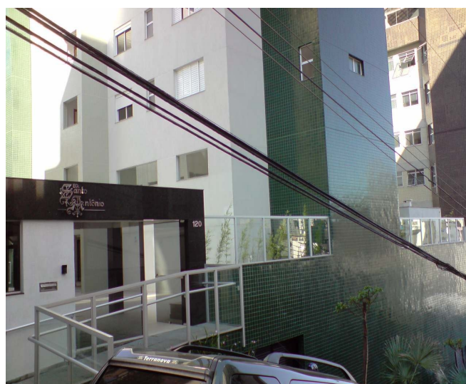
Figura 8 – Foto da fachada (arquivo do autor, 2012)
