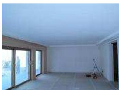
**Figuras 37:** Paredes externa e interna pintada com tinta de silicato
