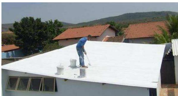
**Figura 39:** Pintura térmica em telhado
