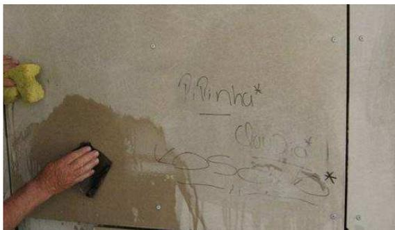
**Figura 38:** Muro com tinta anti-pichação
