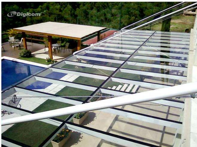
**Figura 33:** Estrutura em alumínio pintado com laca nitrocelulose
