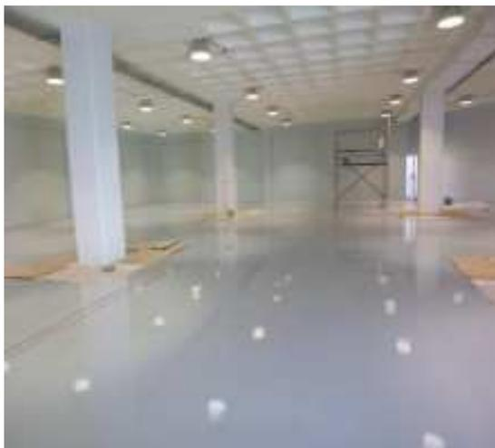
**Figura 30:** Piso revestido com tinta de poliuretano
