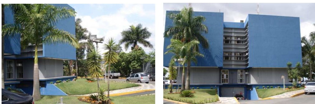
Figuras 46 e 47: Fachadas lateral esquerda da edificação FONTE: arquivo pessoal (2011)
