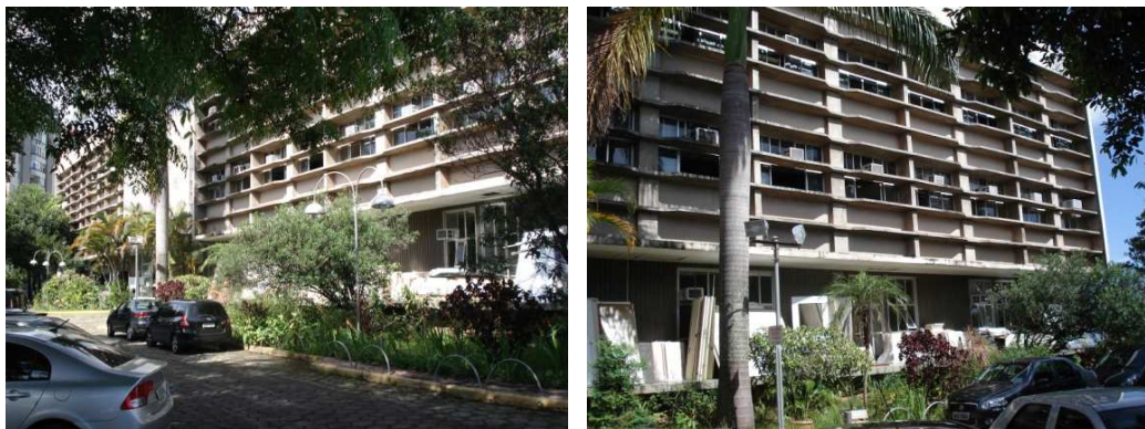
Figuras 30 e 31: Fachada principal da edificação
