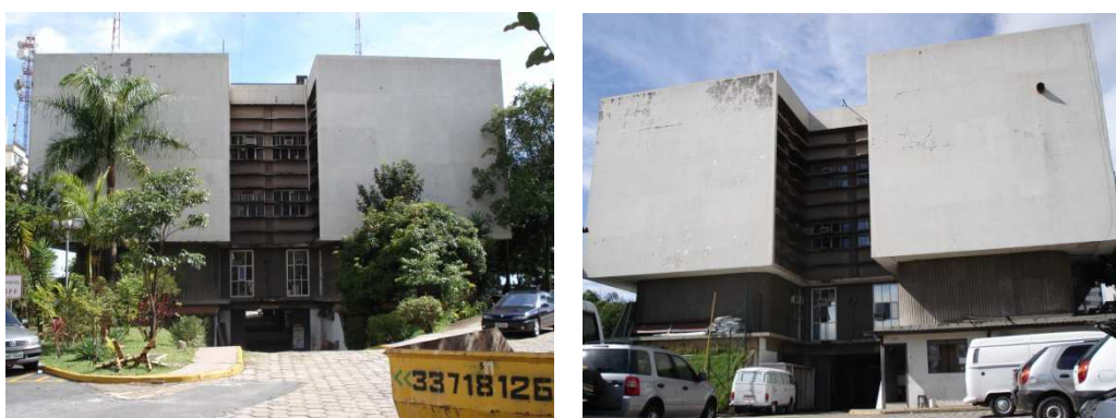
Figuras 34 e 35: Fachada lateral esquerda e lateral direita da edificação
