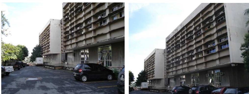
Figuras 32 e 33: Fachada dos fundos da edificação
