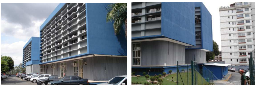
Figuras 44 e 45: Fachadas dos fundos e lateral direita da edificação FONTE: arquivo pessoal (2011)
