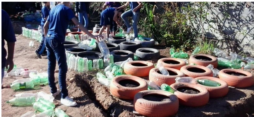
(Figura I – Montagem dos Canteiros)
