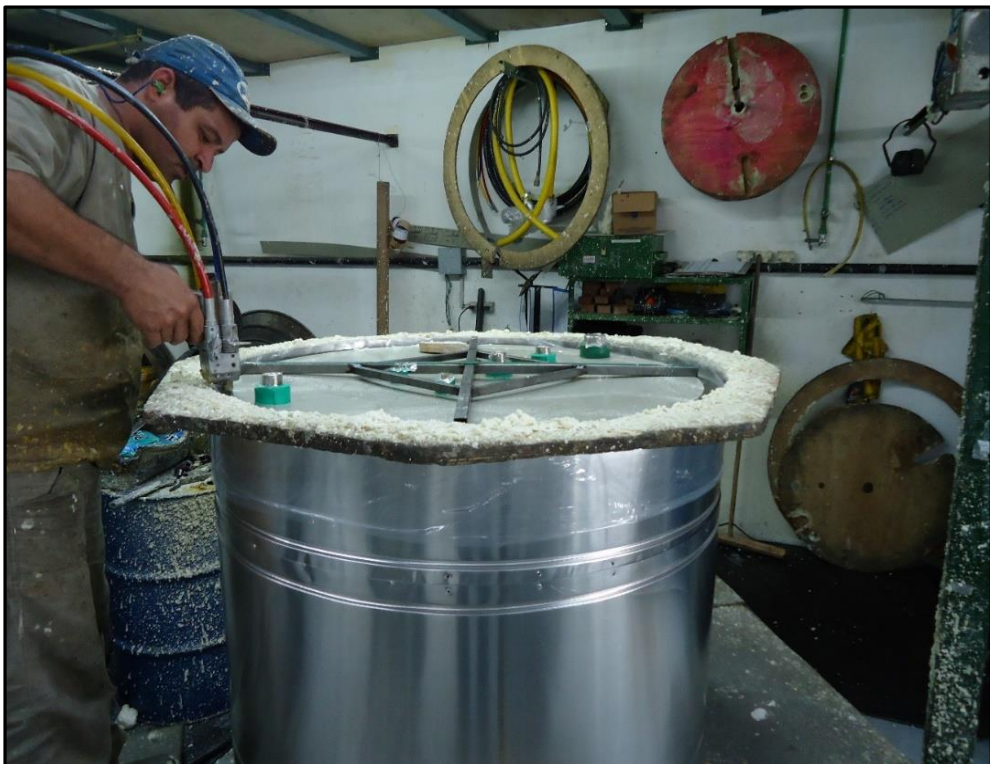
FIGURA 3.10 - Detalhes referentes à aplicação do isolamento no resfriador de gás.
