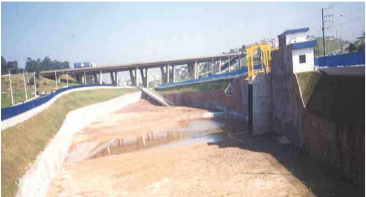
Figura 17 - Reservatório de retenção em Diadema, na região do Ribeirão Capela Fonte: DAEE, 2008
