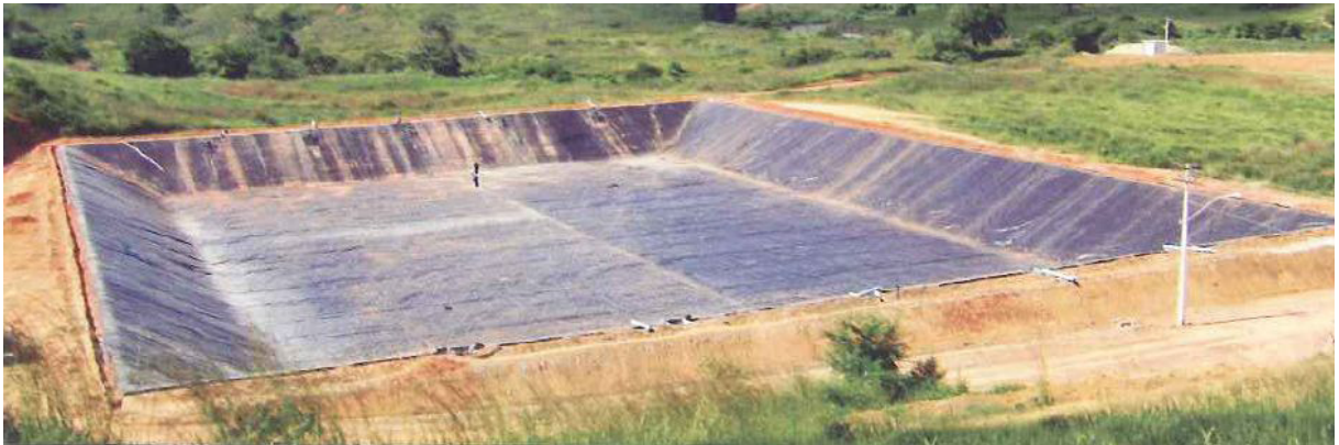
Figura 14 - Execução de bacia de detenção Fonte: Maccaferri, 2011
