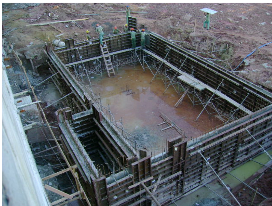
Figura 23- Reservatório de acumulação em fase de concretagem Fonte: SGO Construções, 2011
