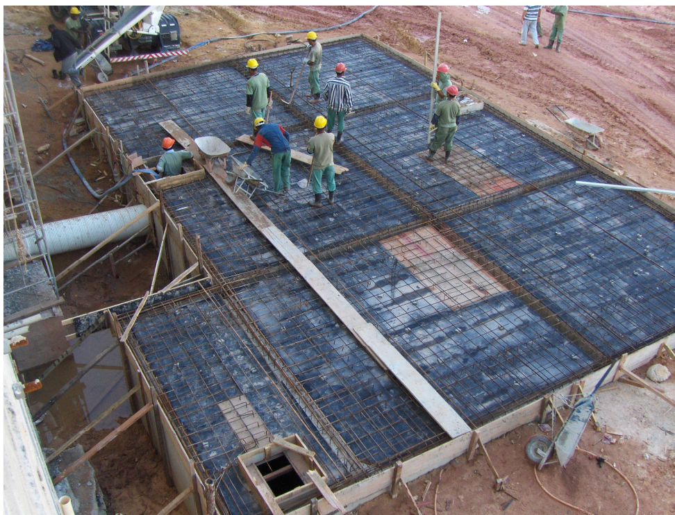
Figura 24 – Execução do fechamento reservatório de acumulação
