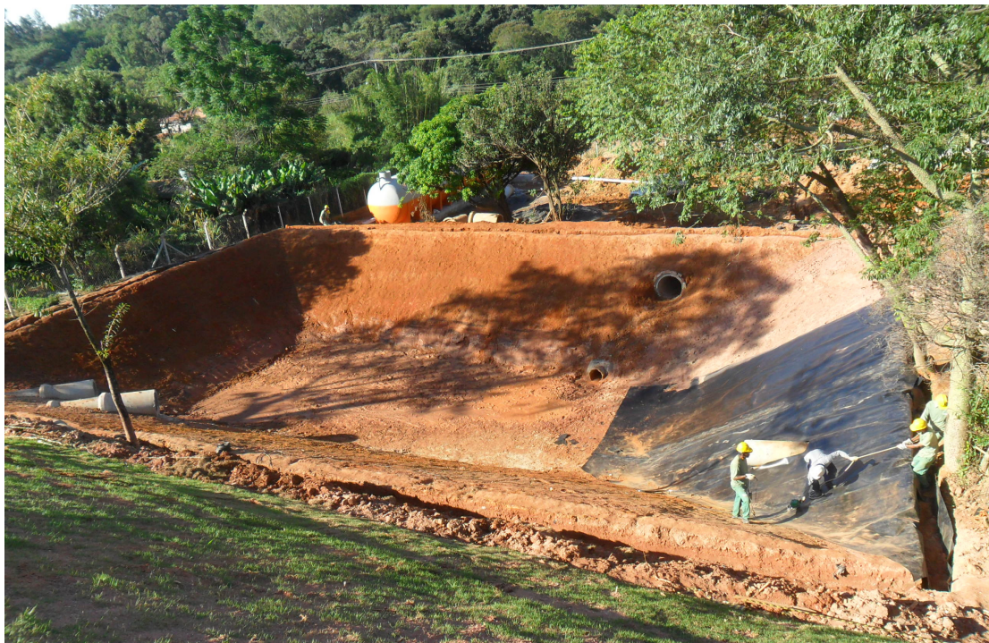
Figura 27- Foto da execução da bacia de retenção Fonte: SGO Construções, 2011
