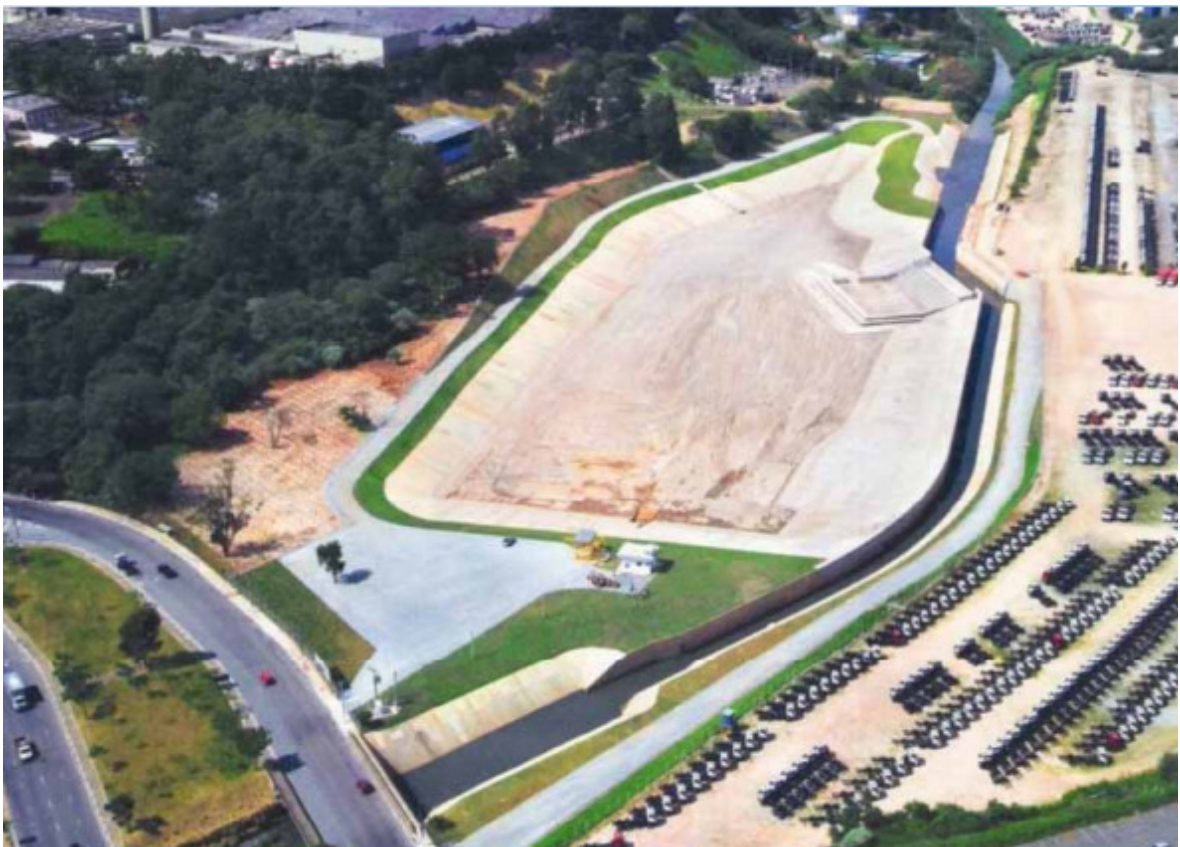
Figura 16 - Reservatório de detenção em São Bernardo do Campo na região do Ribeirão do Couros Fonte: DAEE, 2008
