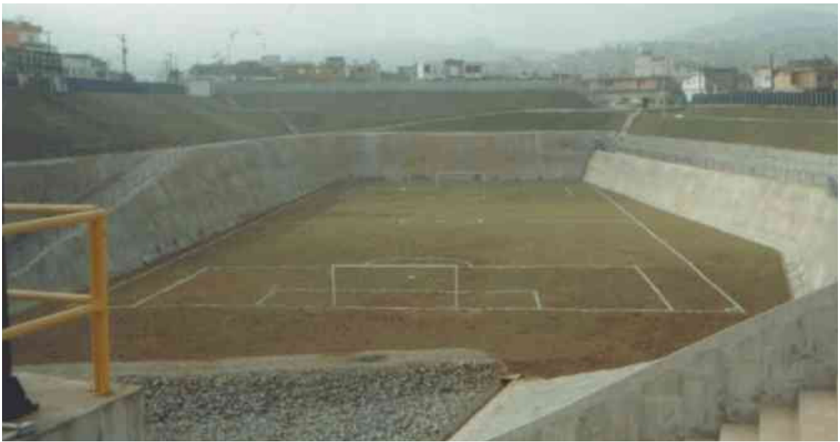
Figura 15 - Reservatório de detenção em São Bernardo do Campo na região do Alto Tamanduatei. Fonte: DAEE, 2000.
