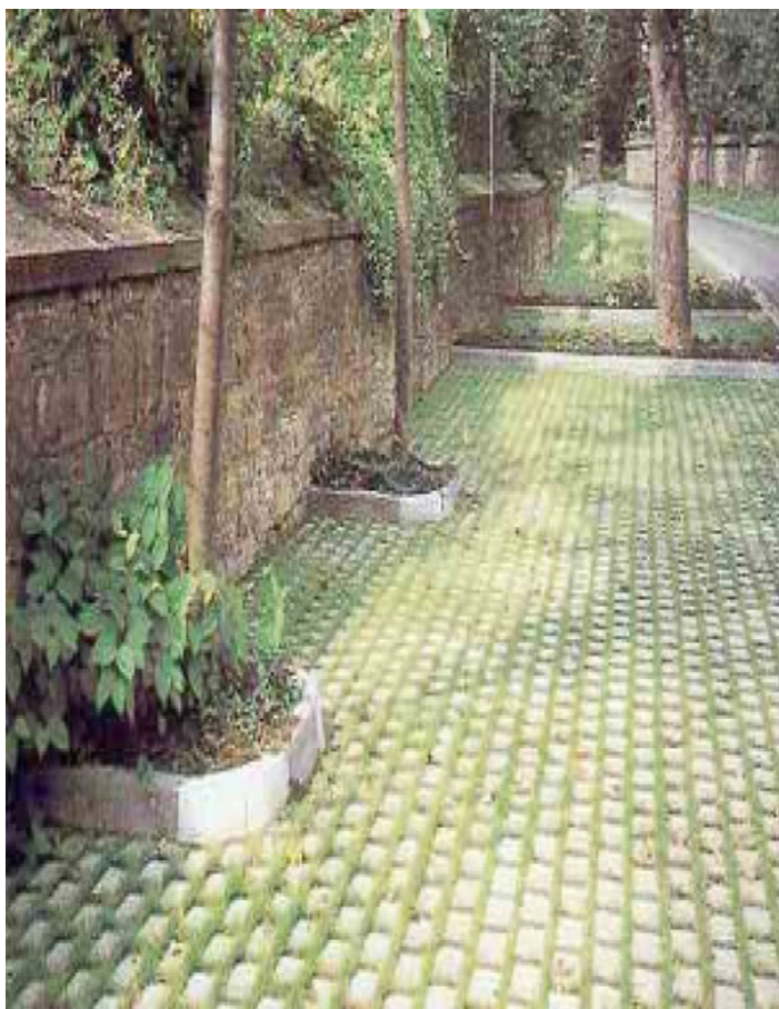
Figura 10- Aplicação piso drenante, Araújo, et al., 2000
