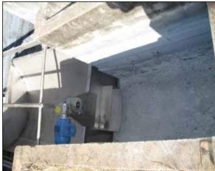
Figura 4.4 – Canal de entrada – Peneira Estática Auto-limpante
