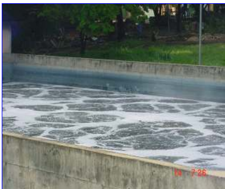
Figura 4.6 – Segundo tanque de Equalização
