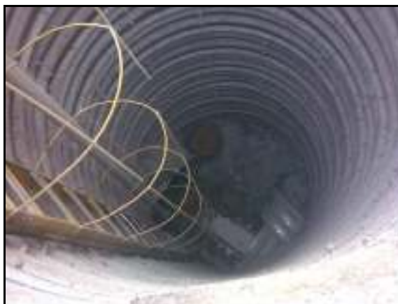
Figura 3.8 – Poço de ataque (foto do autor)
