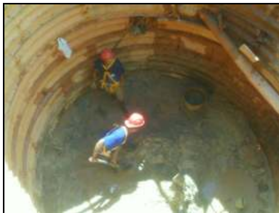
Figura 3.3 – Escavação manual para execução de túnel (foto do autor)
