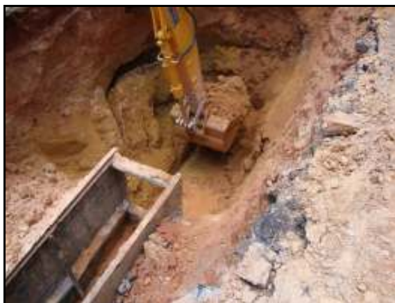
Figura 3.2 – Escavação mecânica em solo com água (foto do autor)
