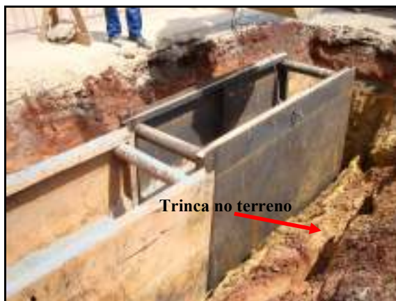
Figura 5.2 – Colocação de escoramento blindado (foto do autor)
