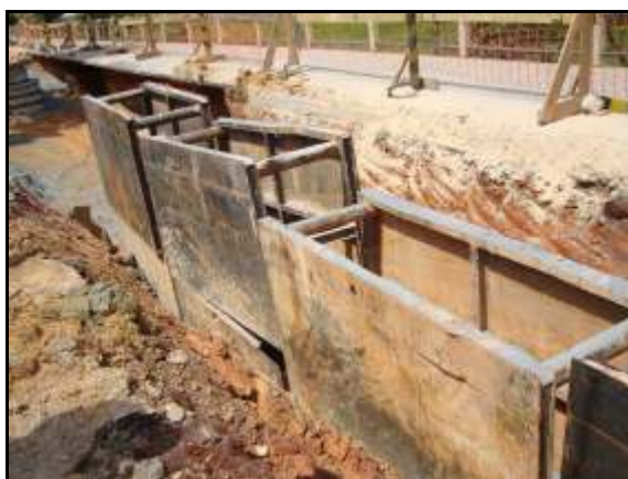
Figura 3.7 – Escoramento blindado (foto do autor)
