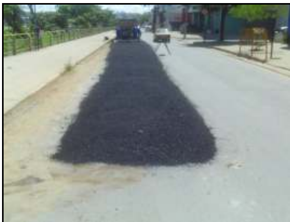
Figura 5.3 – Recomposição em vala normal (foto do autor)
