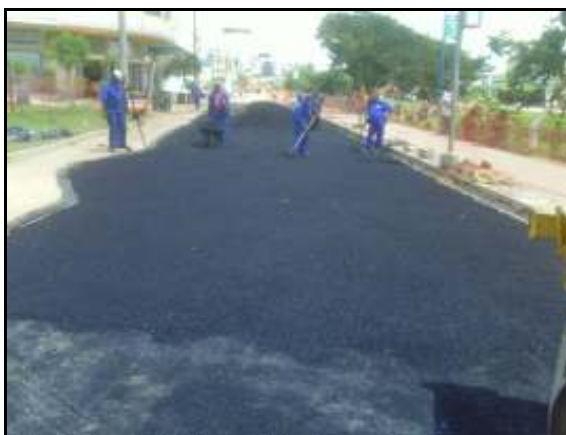
Figura 5.4 – Recomposição em vala com desmoronamento (foto do autor)
